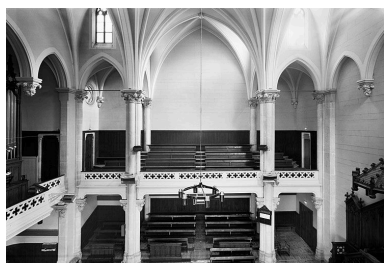
Eglise, vue générale du côté nord Phot. Eric Dessert IVR82_20046900517P
