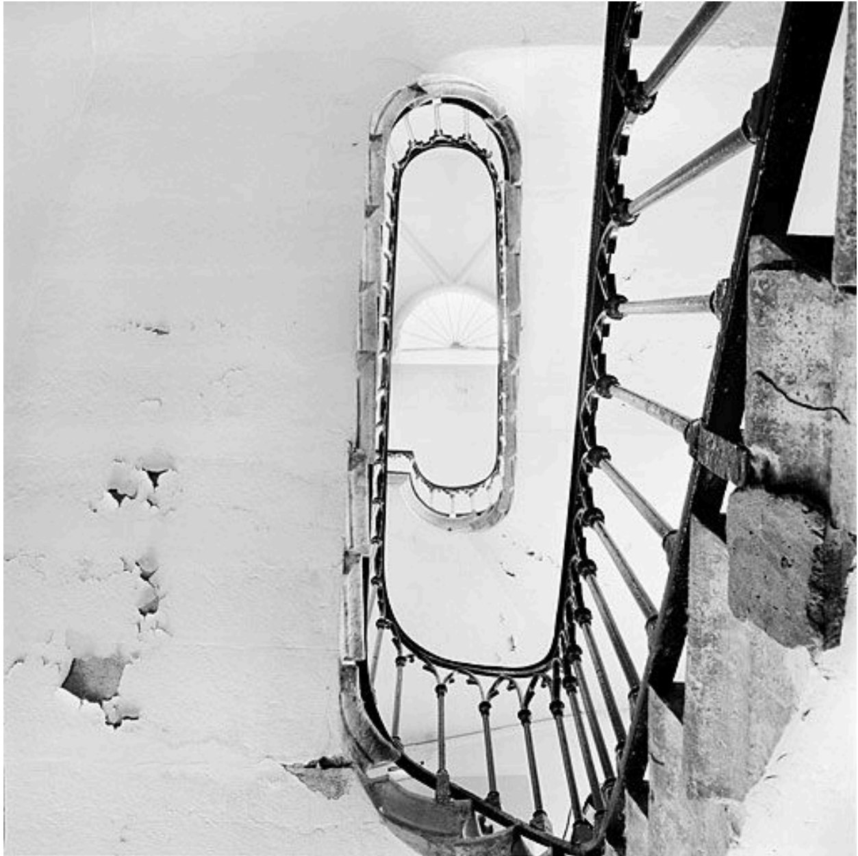
Bâtiment à étages, escalier de gauche, vue générale du jour par-dessous
