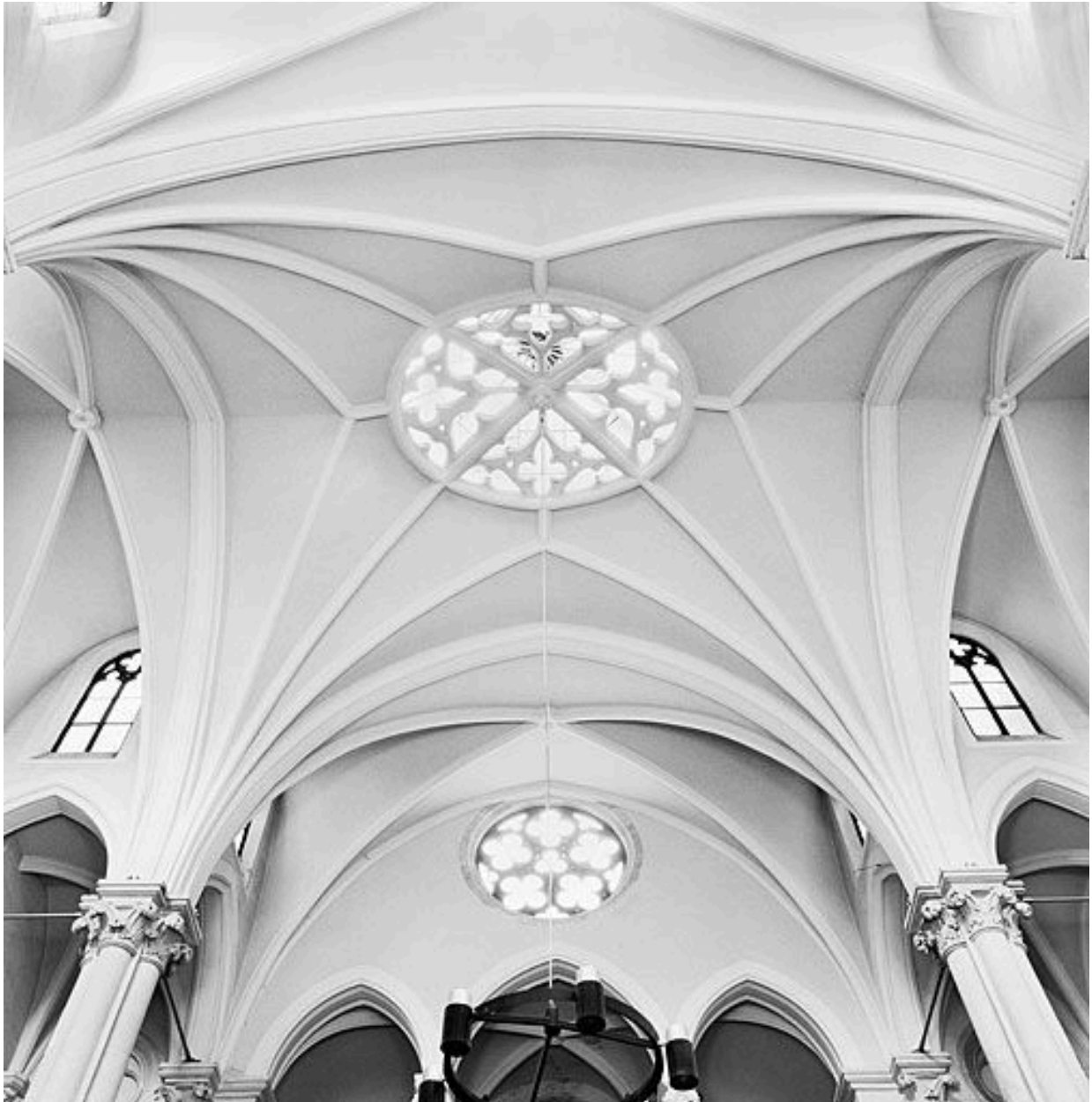
Eglise, vue du couvrement
