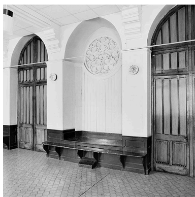
Bâtiment à étages, salle du premier étage, détail de la niche et des portes-fenêtres du côté de l'ancienne cour couverte
