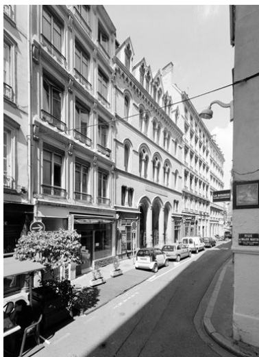
Vue générale de la façade Phot. Didier Gourbin IVR82_20056902666V
