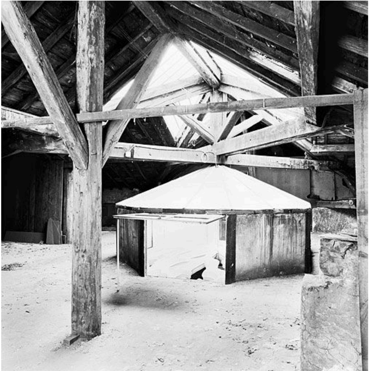
Eglise, comble et tambour protégeant l'ouverture zénithale de la voûte
