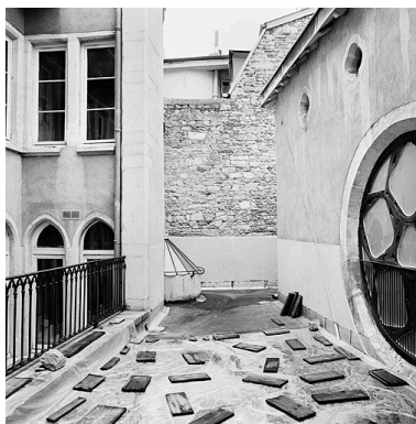
Eglise, couverture en terrasse du côté du bâtiment à étages Phot. Eric Dessert IVR82_20046900492X
