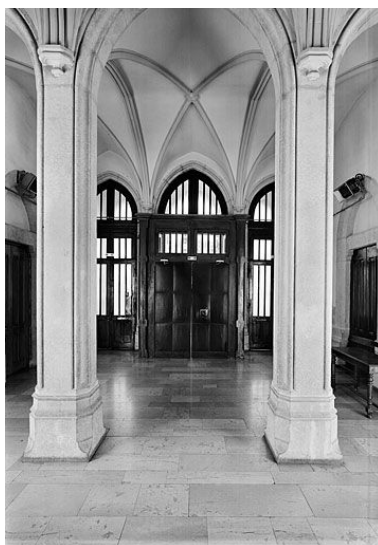
Bâtiment à étages, vestibule, vue vers l'entrée
