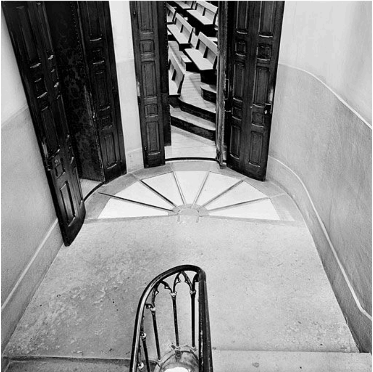
Bâtiment à étages, escalier de droite, deuxième repos du rez-de-chaussée d'escalier
