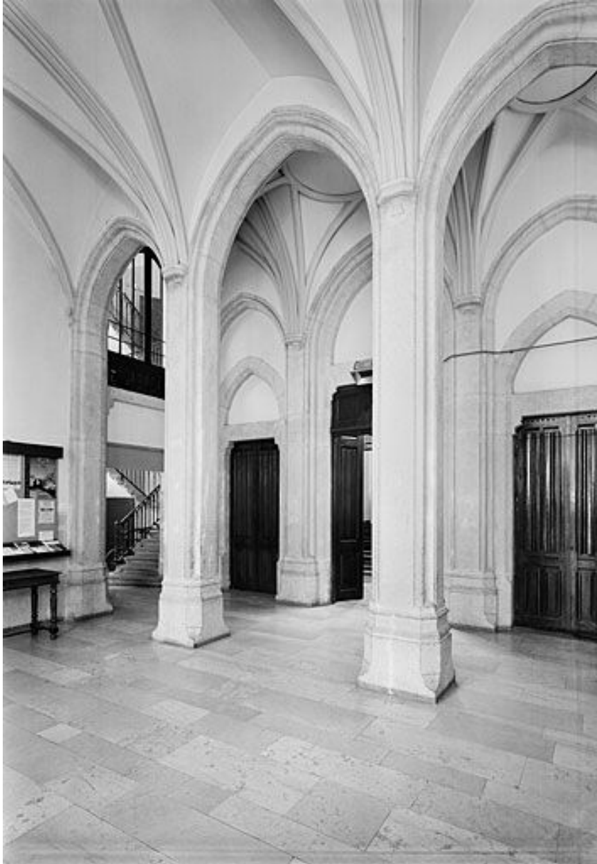
Bâtiment à étages, vestibule, vue de trois quarts vers l'escalier de gauche et l'entrée de l'église
