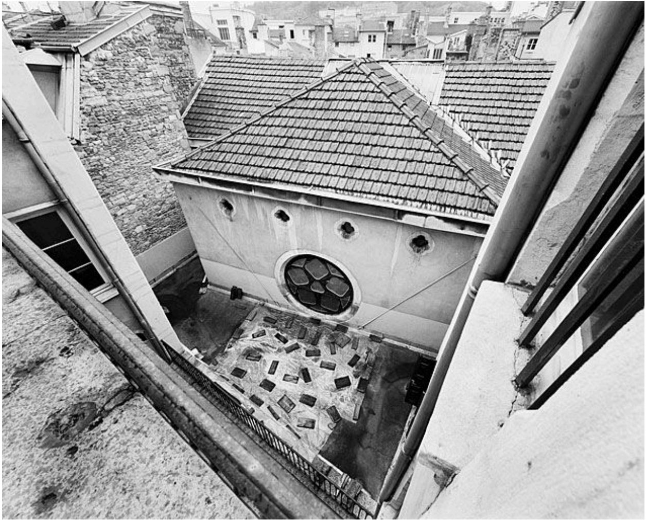
Eglise, vue générale du toit
