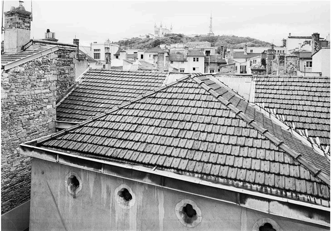
Eglise, toiture, partie couverte par des longs pans
