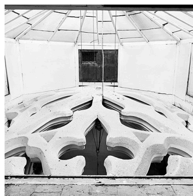
Eglise, combles, ouverture zénithale Phot. Eric Dessert IVR82_20046900522X
