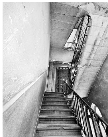
Bâtiment à étages, escalier de droite, vue générale des parties hautes Phot. Eric Dessert IVR82_20046900503V
