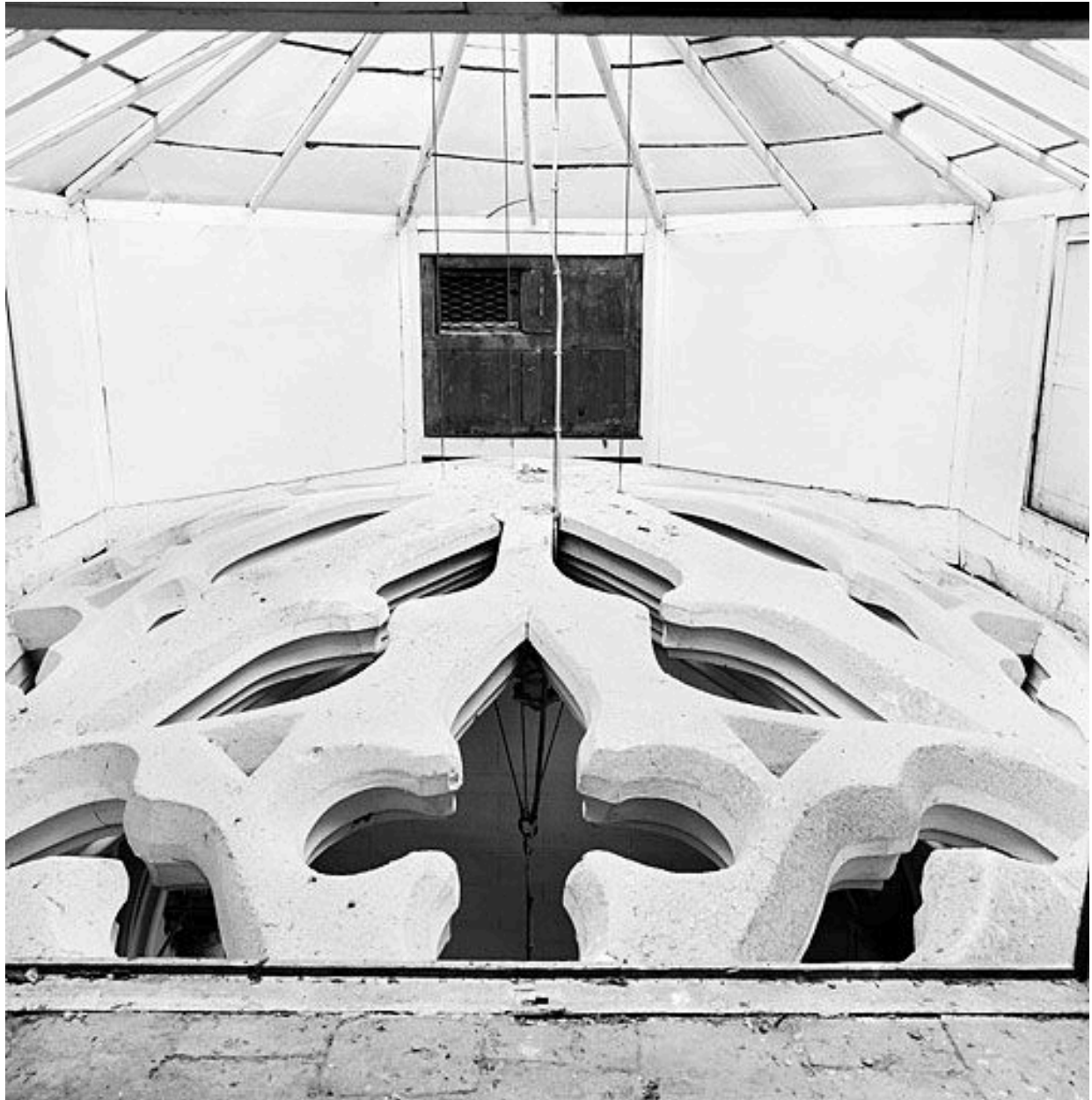
Eglise, combles, ouverture zénithale
