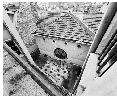
Eglise, vue générale du toit Phot. Eric Dessert IVR82_20046900490V
