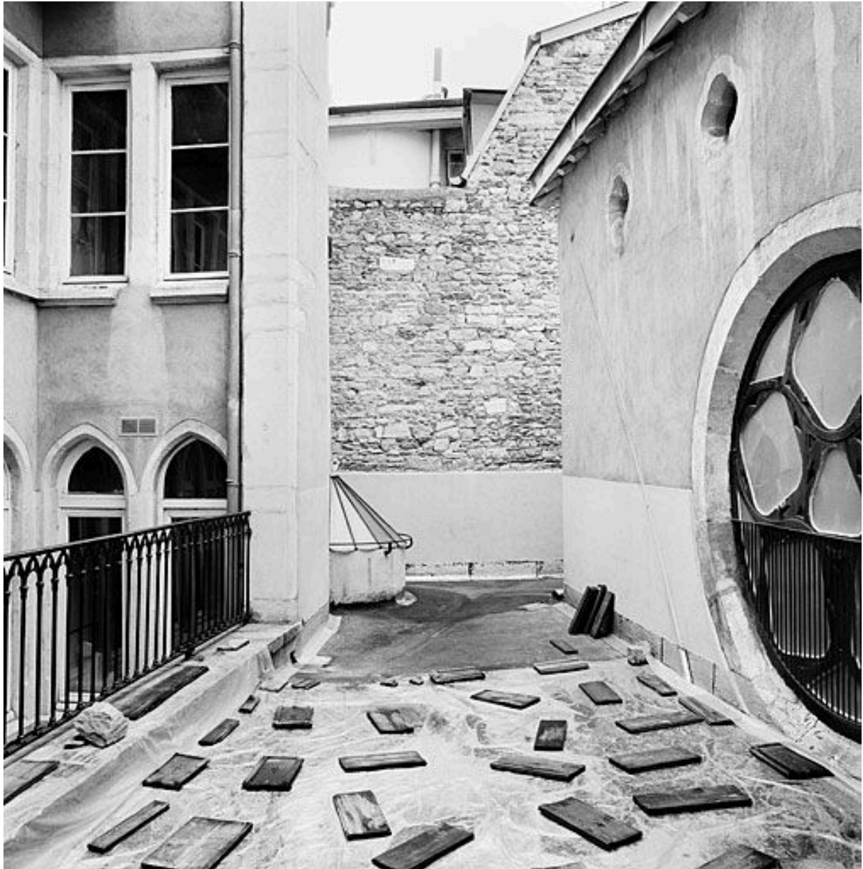
Eglise, couverture en terrasse du côté du bâtiment à étages
