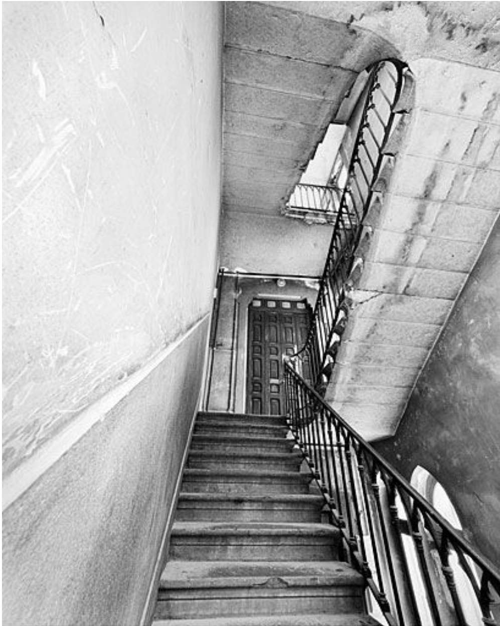
Bâtiment à étages, escalier de droite, vue générale des parties hautes
