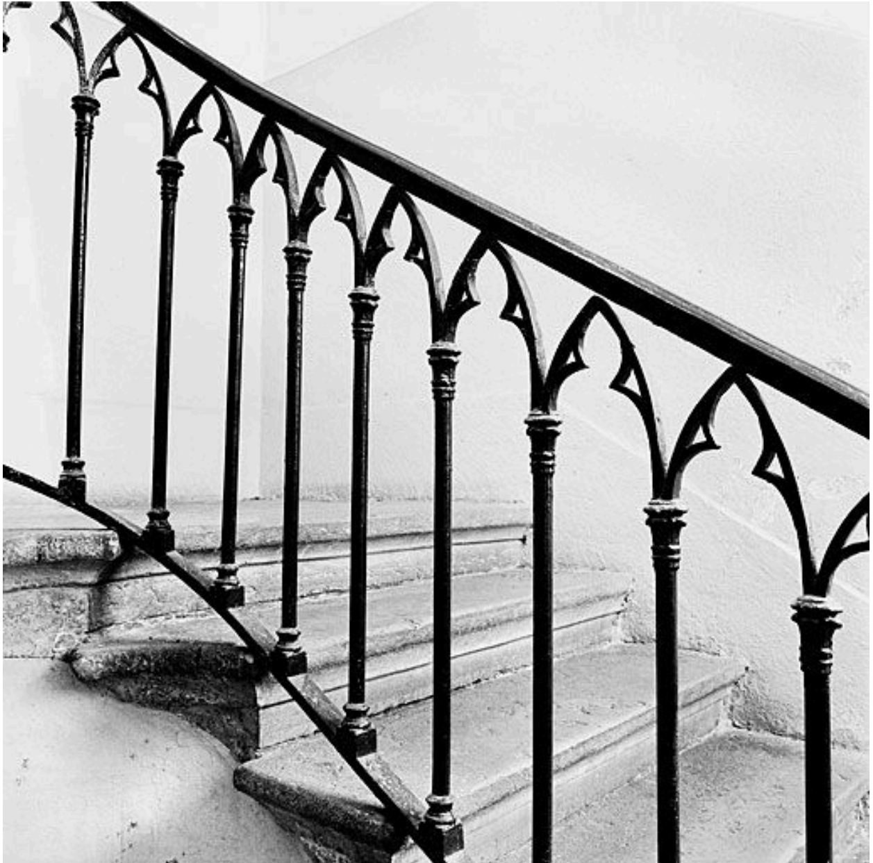
Bâtiment à étages, escalier de gauche, détail de la rampe
