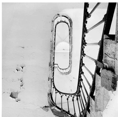
Bâtiment à étages, escalier de gauche, vue générale du jour par-dessous Phot. Eric Dessert IVR82_20046900497X
