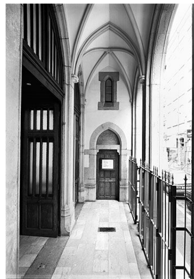
Bâtiment à étages, porche Phot. Eric Dessert
