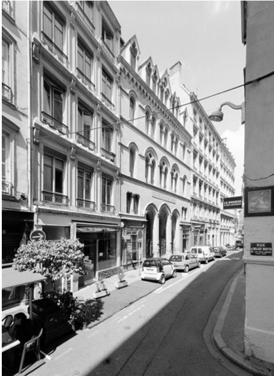
Vue générale de la façade
