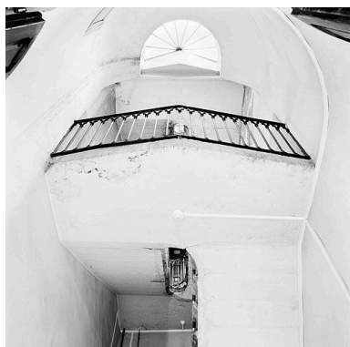
Bâtiment à étages, escalier de droite, repos du premier étage d'escalier et rétrécissement de la cage au-dessus Phot. Eric Dessert IVR82_20046900501X
