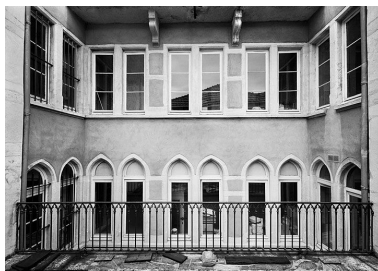
Bâtiment à étages, élévation postérieure, élévation des 2e et 3e étages Phot. Eric Dessert IVR82_20046900488P
