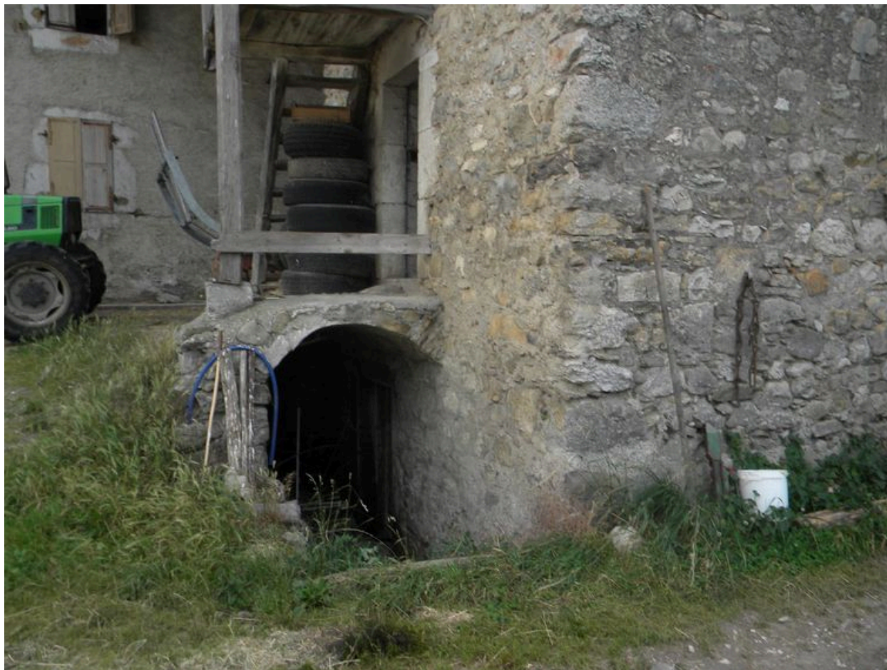
Vue de l'entrée de la cave voutée en berceau.
