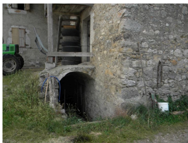
Vue de l'entrée de la cave voûtée en berceau. Phot. Jérôme Daviet IVR82_20127400531NUCA
