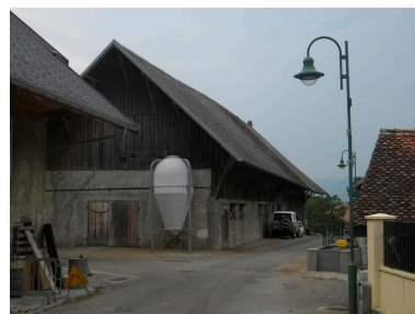
Vue des parties transformées de la ferme. Phot. Jérôme Daviet IVR82_20127400648NUCA
