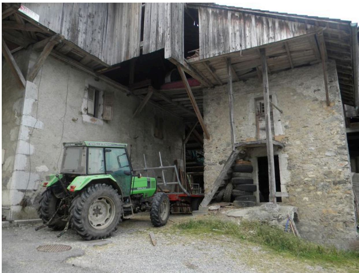
Vue de l'annexe près de la ferme principale.
