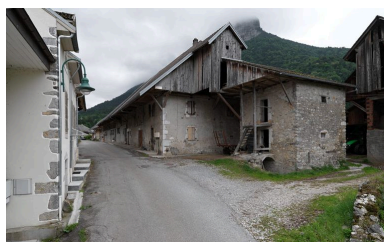
Vue générale de la ferme depuis la route de Chevaline. Phot. Eric Dessert IVR82_20117400141NUCA
