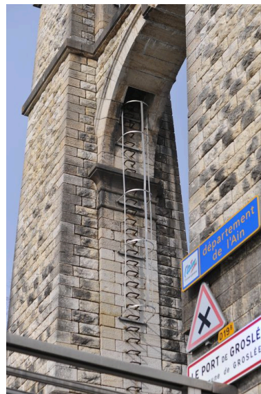
Pylône droit, face amont, vue partielle : accès au sommet, partie inférieure (depuis la rive droite) Phot. G. Gellert IVR82_20100100486NUCA
