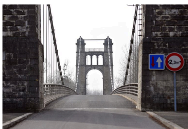
Vue partielle, de dessus, chaussée et pylône gauche (depuis la rive droite) Phot. G. Gellert IVR82_20100100481NUCA
