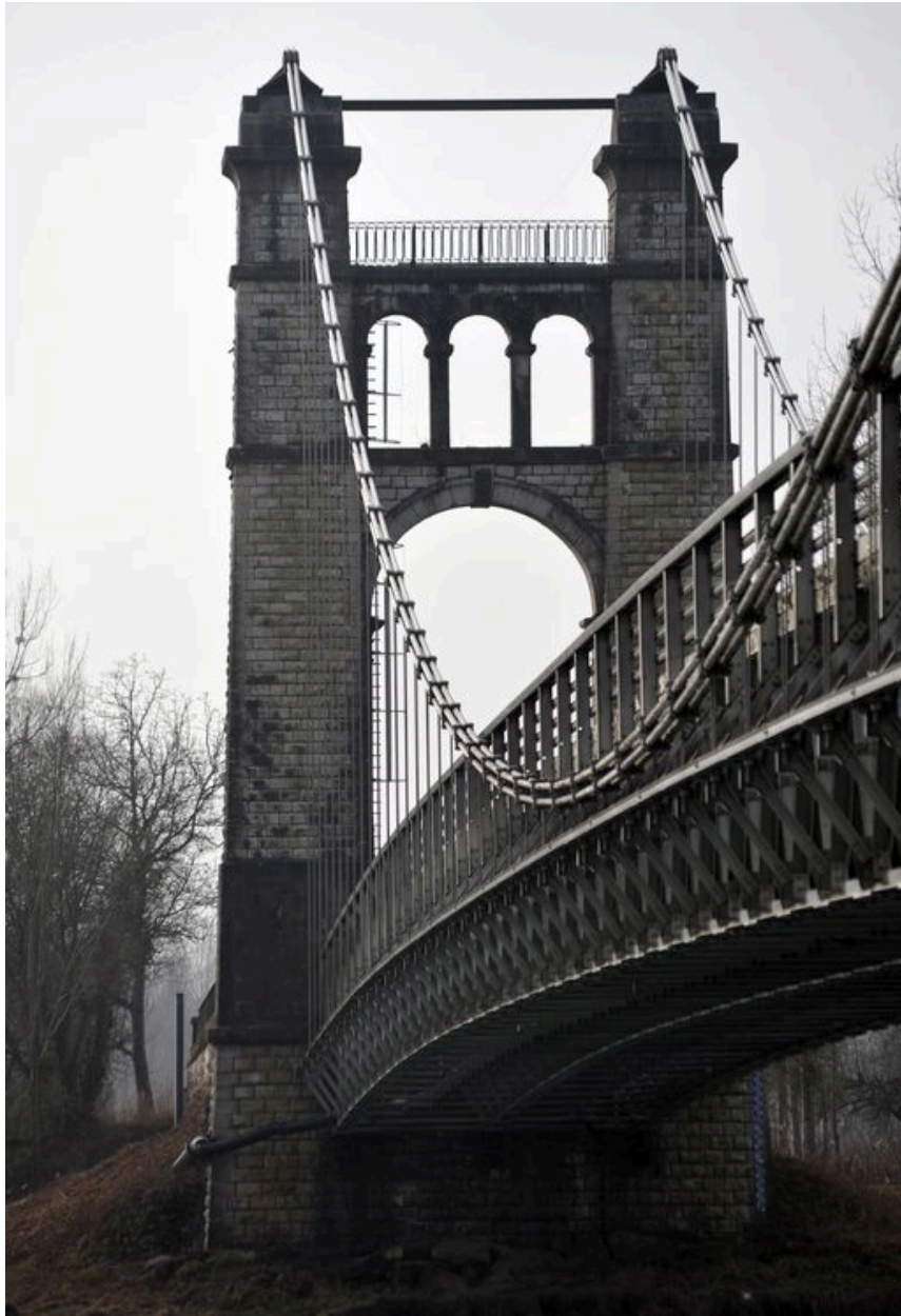
Vue partielle, de côté, pylône gauche, face amont (depuis la rive droite)
