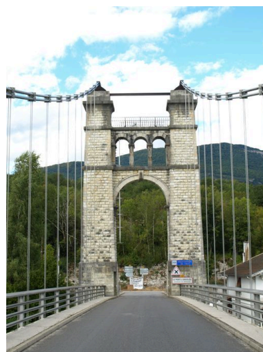
Vue partielle, de dessus, suspentes et câbles porteurs, pylône droit (depuis la rive gauche) Phot. J. Marasi IVR82_20100100482NUCA
