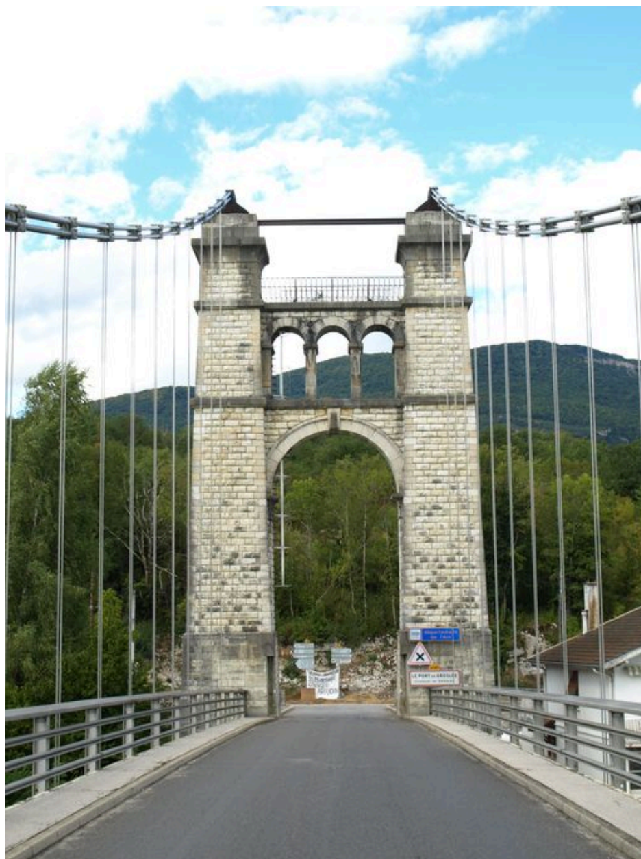
Vue partielle, de dessus, suspentes et câbles porteurs, pylône droit (depuis la rive gauche)
