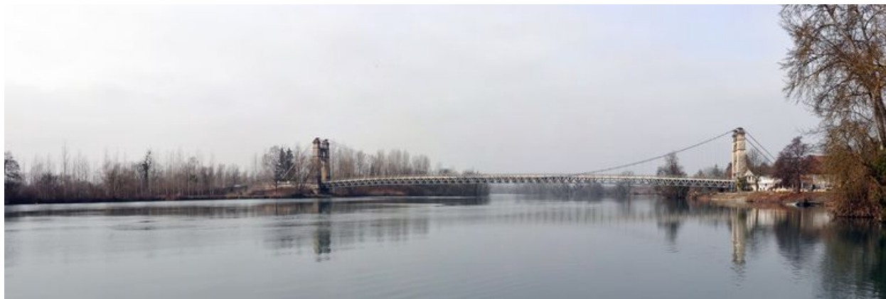
Vue panoramique, face amont (depuis la rive droite)
