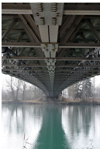
Vue générale, de dessous, tablier (depuis la rive droite) Phot. G. Gellert IVR82_20100100487NUCA
