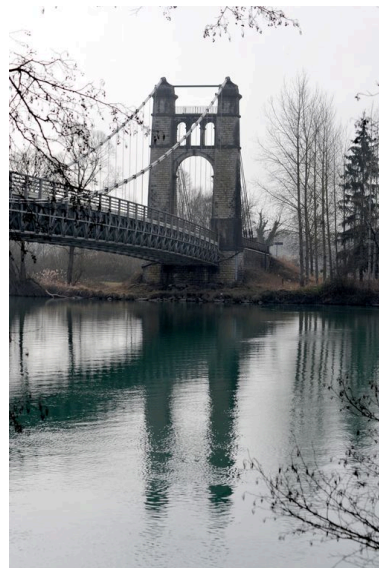
Vue partielle, de côté, face aval (depuis la rive droite) Phot. G. Gellert IVR82_20100100474NUCA
