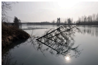
Vue partielle, face amont (depuis la rive gauche) Phot. G. Gellert IVR82_20100100472NUCA
