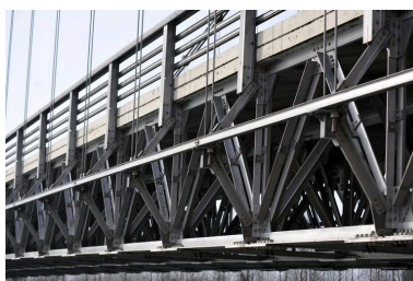
Travée centrale, face amont, vue de détail : jonction des suspentes avec la structure métallique du tablier (depuis la rive droite) Phot. G. Gellert IVR82_20100100479NUCA
