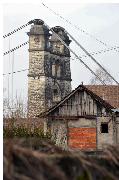
Pylône droit, face amont, vue générale (depuis la rive droite) Phot. G. Gellert IVR82_20100100483NUCA
