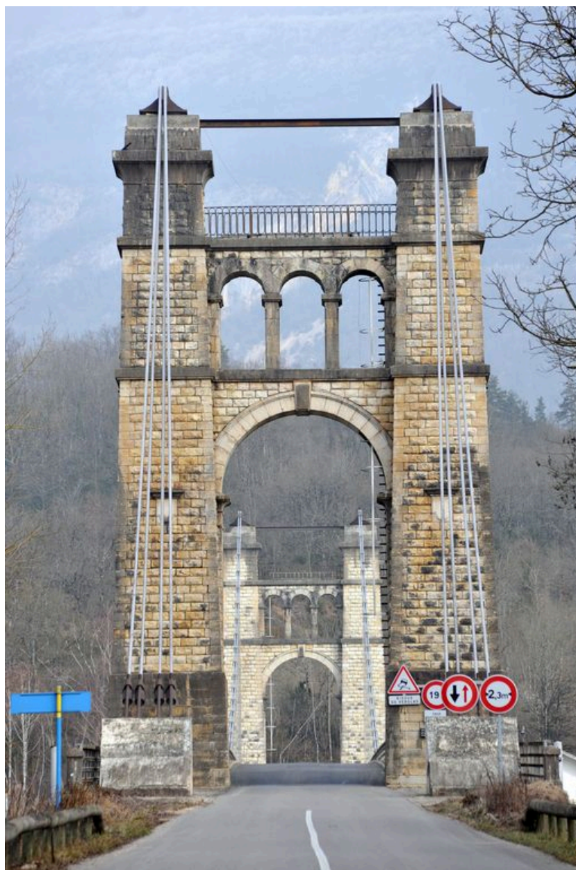
Vue générale, de dessus, chaussée (depuis la rive gauche)
