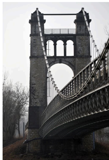
Vue partielle, de côté, pylône gauche, face amont (depuis la rive droite) Phot. G. Gellert IVR82_20100100477NUCA
