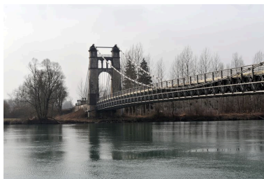
Vue partielle, face aval (depuis la rive gauche) Phot. G. Gellert IVR82_20100100473NUCA
