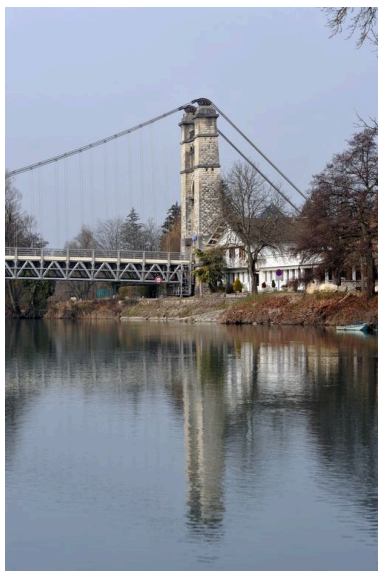
Vue partielle, pylône droit, face amont (depuis la rive droite) Phot. G. Gellert IVR82_20100100476NUCA
