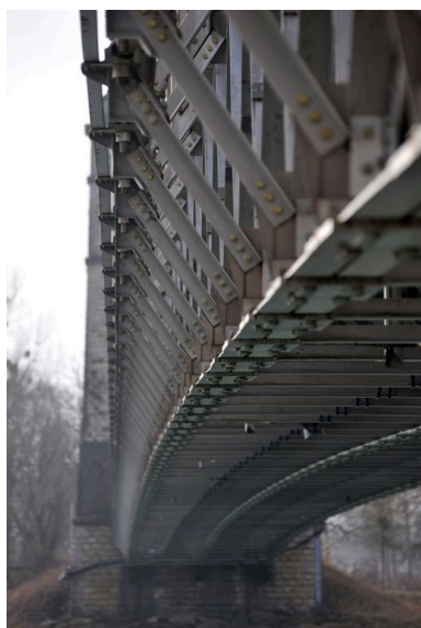
Travée centrale, face amont, vue partielle : structure métallique (depuis la rive droite) Phot. G. Gellert IVR82_20100100478NUCA
