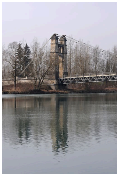
Vue partielle, pylône gauche, face amont (depuis la rive droite) Phot. G. Gellert IVR82_20100100475NUCA
