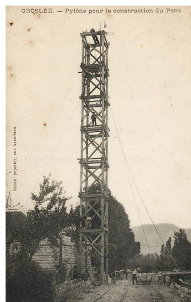
Groslée - Pylône pour la construction du Pont / Perrin pap. Les Avenièrès : Perrin, [1ère moitié du 20e siècle]. 1 impr. photoméc. (carte
