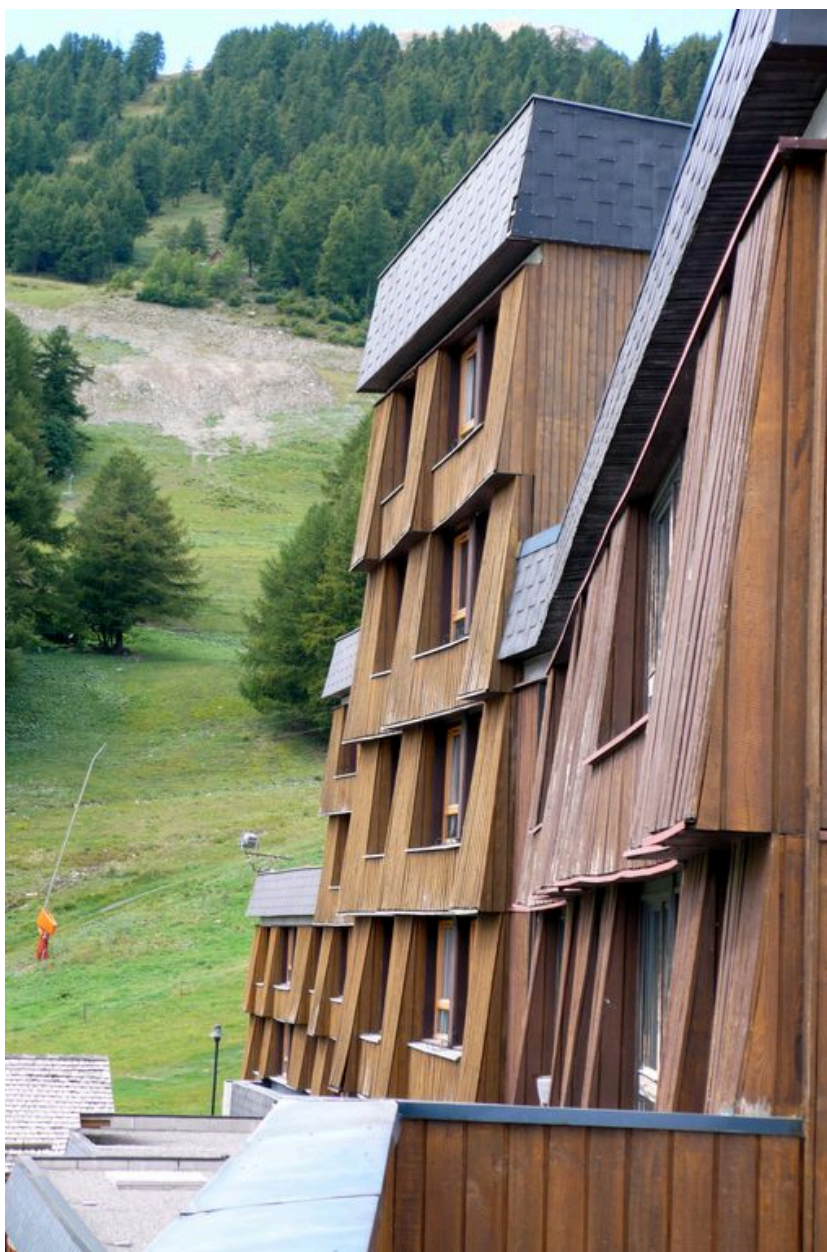
Détail de la structure de la façade
