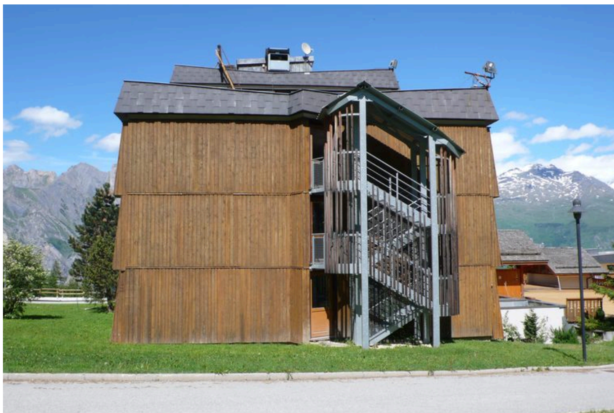
Elévation latérale. Escalier de secours rapporté
