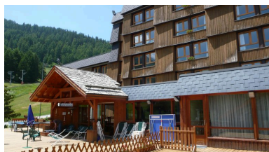
L'entrée sur la terrasse Phot. Jean-François Lyon-Caen IVR82_20127302261NUCA
