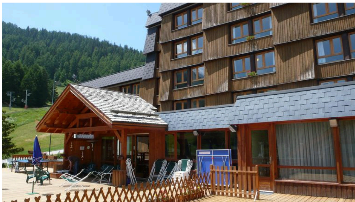
L'entrée sur la terrasse
