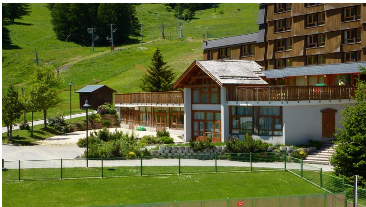
Façade sud-est. L'entrée sous la terrasse
