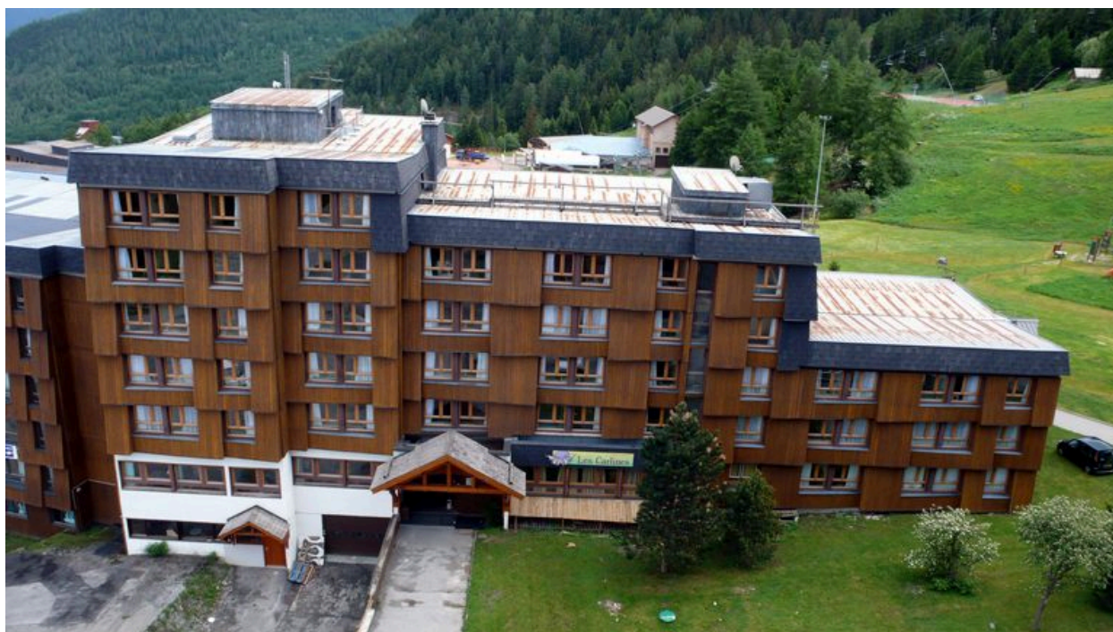
Vue plongeante depuis le nord-ouest
