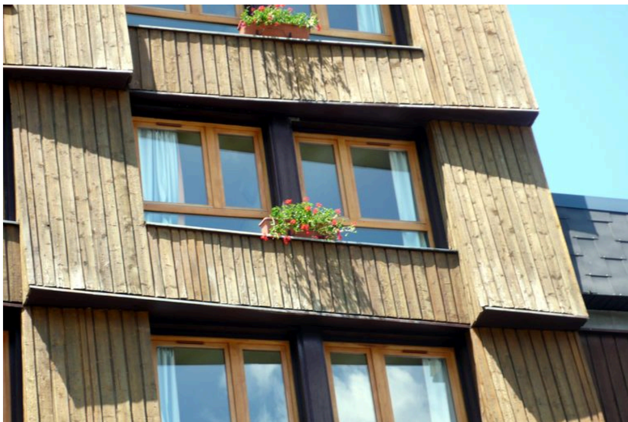
Détail de la structure de la façade et de l'essentage de planches
