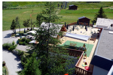
Vue générale de la terrasse rajoutée en 1998 Phot. Jean-François Lyon-Caen IVR82_20127302260NUCA
