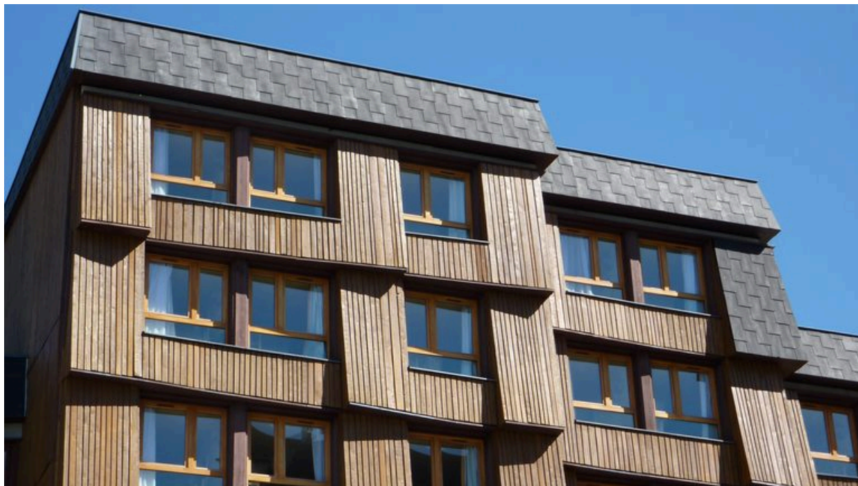
Détail des corniches en bordure de toiture
