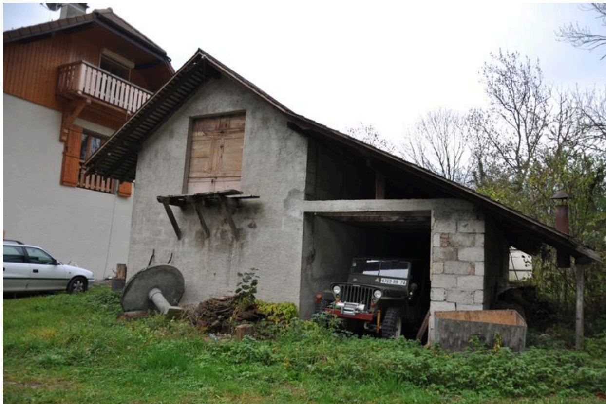
Vue du mur pignon sud-est de la remise
