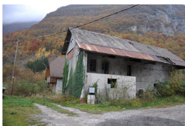
Vue de l'élévation nord-ouest de la scierie Phot. Samir Mahfoudi, Autr. Samir Mahfoudi IVR82_20117401292NUCA
