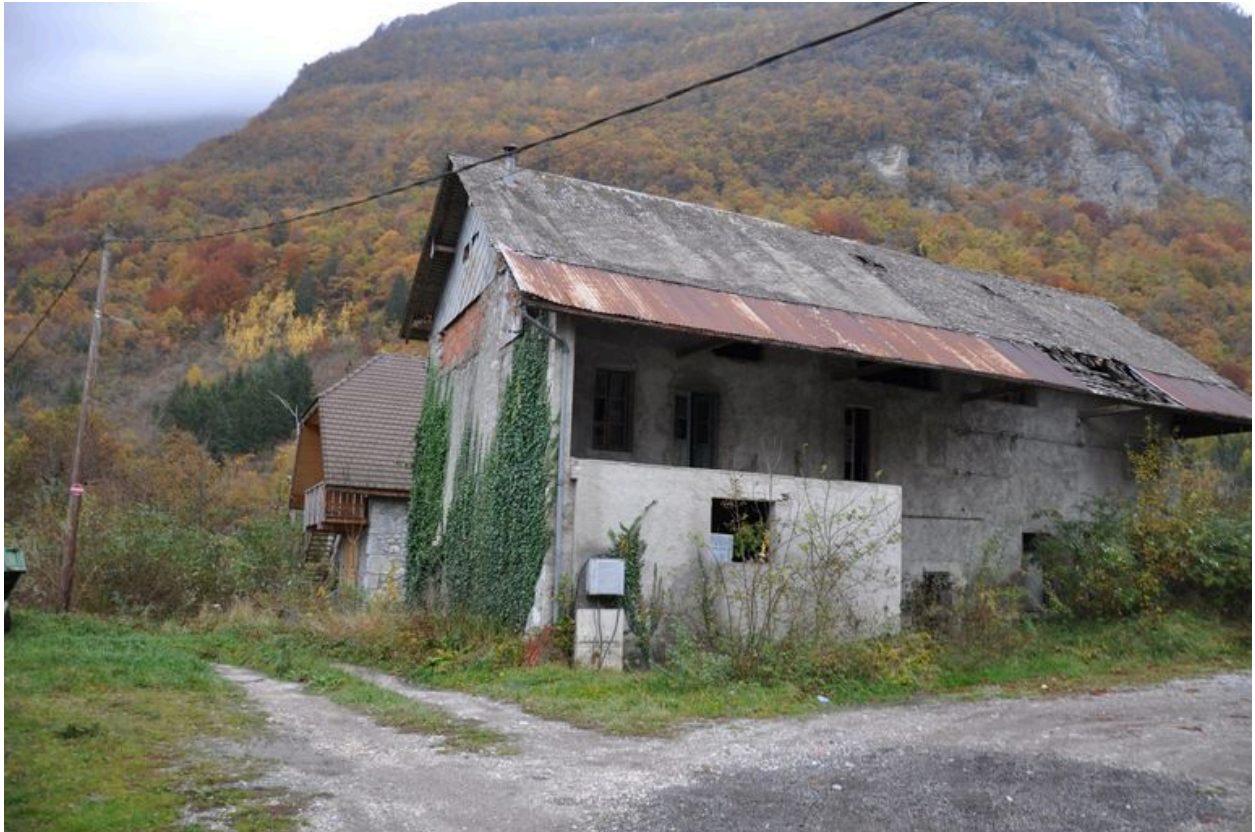
Vue de l'élévation nord-ouest de la scierie
