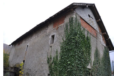
Vue de l'élévation nord-est de la scierie Phot. Samir Mahfoudi, Autr. Samir Mahfoudi IVR82_20117401293NUCA
