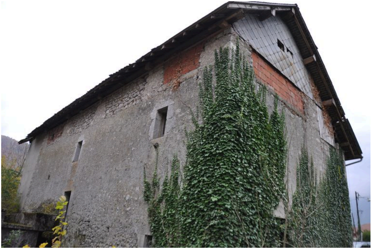
Vue de l'élévation nord-est de la scierie
