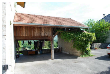
Vue d'ensemble du préau. Phot. Thierry Monnet IVR84_20187400408NUCA
