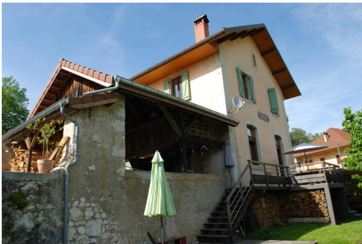
Vue d'ensemble arrière de l'école.
