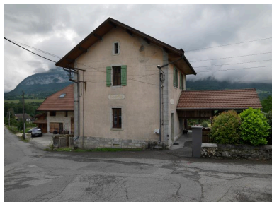
Vue d'ensemble de l'école de Lachat. Phot. Thierry Leroy IVR82_20157402589NUCAQ
