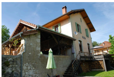
Vue d'ensemble arrière de l'école. Phot. Thierry Monnet IVR84_20187400409NUCA
