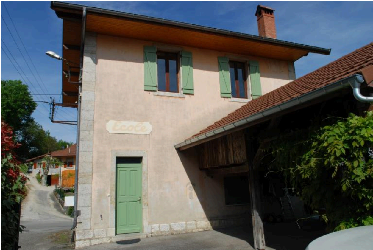
Vue d'ensemble de la façade avant.
