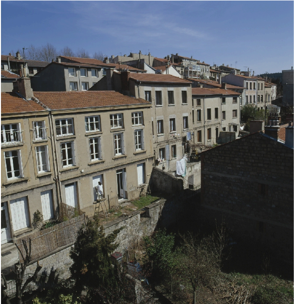
Façade principale avec vue partielle du 78 rue Royet et de l'implantation en milieu de parcelle
