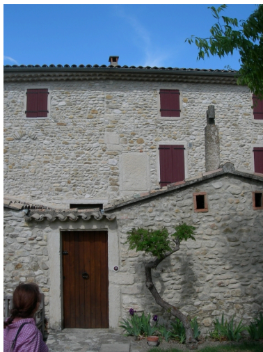
Vue partielle de l'élévation sud du logis sur cour et du four à pain. Phot. Annie Tosi-Remy IVR82_20062600057NUCA
