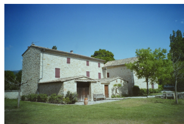
Vue d'ensemble prise du sud-ouest : bergerie et four à pain au 1er plan, corps de logis derrière.
