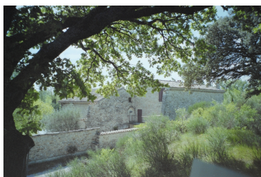
Vue d'ensemble, prise du nord-est. Phot. Geneviève Jourdan IVR82_20062600053ZE
