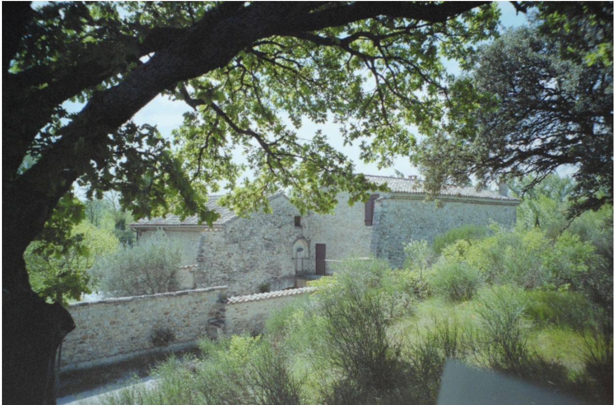
Vue d'ensemble, prise du nord-est.
