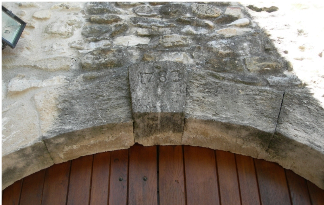
Détail de la porte donnant sur la cour nord : clef datée 1783.
