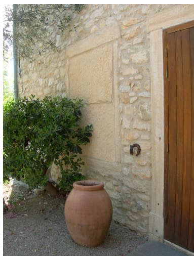
Aile en retour, détail de l'élévation est. Phot. Annie Tosi-Remy IVR82_20062600059NUCA
