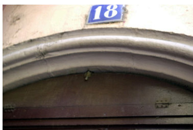
Porte, détail de la moulure Phot. Lore Derail IVR82_20036901386NUCA
