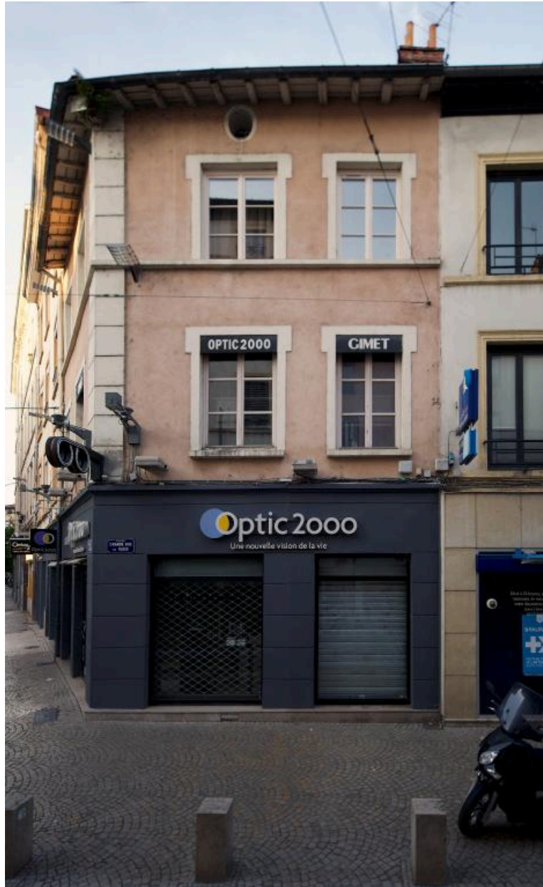
Elévation sur la grande rue de Vaise
