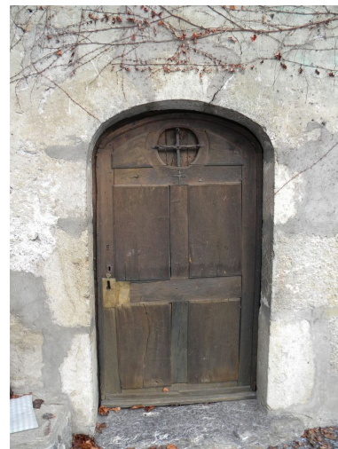
Porte en plein ceintre de la cave. Phot. Jérôme Daviet IVR82_20107402524NUCA
