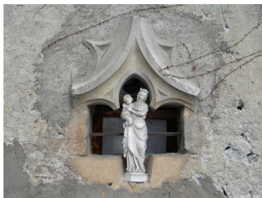
Détail de la baie trilobée provenant peut-être de l'ancienne chapelle. Phot. Jérôme Daviet IVR82_20107402523NUCA
