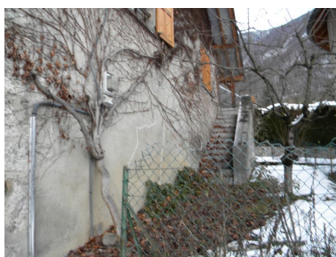
Pignon sud avec départ de l'escalier en marbre de Doussard.
