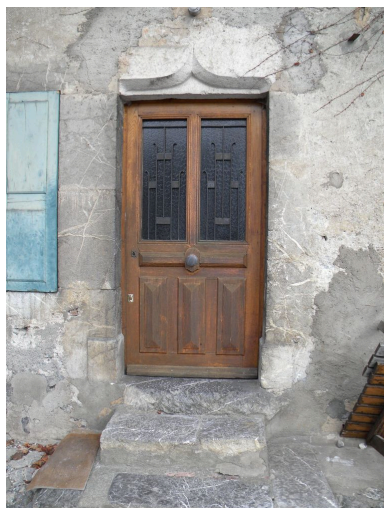
Porte d'entrée avec linteau en accolade de réemploi. Phot. Jérôme Daviet IVR82_20107402525NUCA
