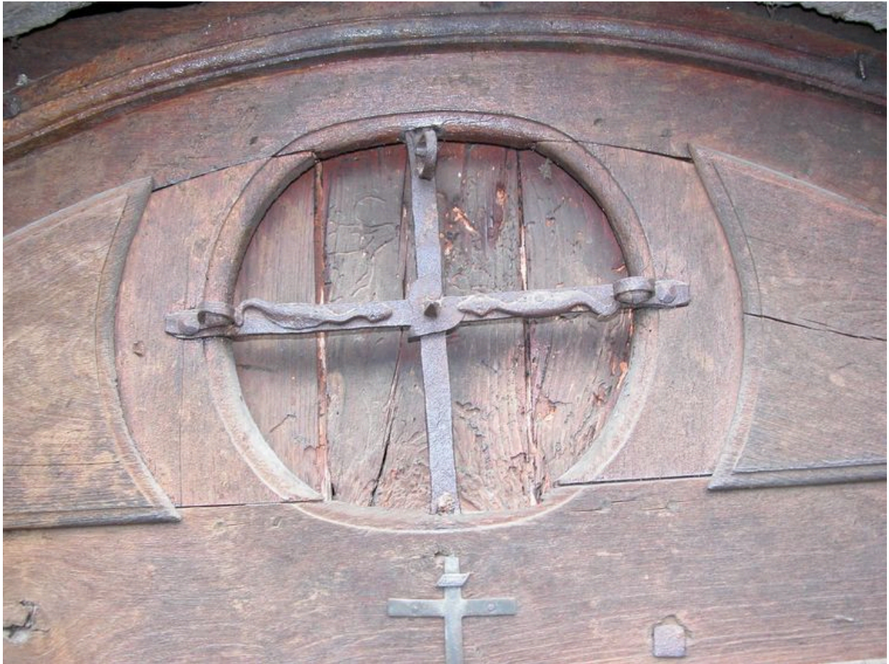
Détail d'oculus sur la porte de cave en façade principale.
