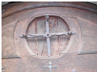
Détail d'occulus sur la porte de cave en façade principale. Phot. Jérôme Daviet IVR82_20107402522NUCA
