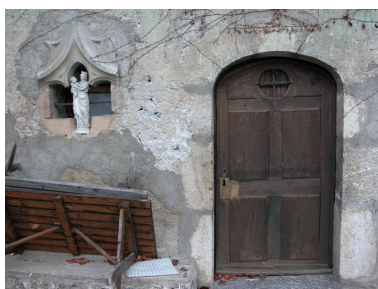
Baie trilobée et porte de cave en plein cintre. Phot. Jérôme Daviet IVR82_20107402516NUCA
