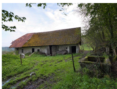
Vue d'ensemble de face. Phot. Thierry Leroy IVR82_20157303897NUCAQ
