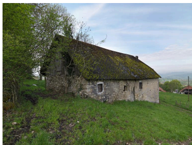
Vue d'ensemble de trois-quart arrière gauche. Phot. Thierry Leroy IVR82_20157303894NUCAQ
