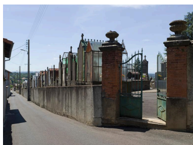
La rue longeant le cimetière des Limandons, dans sa partie médiane (troisième tronçon, entre l'avenue des Etats-Unis et la rue Antonine-Planche). Phot. Jean-Michel Périn IVR83_20116300757NUC4A
