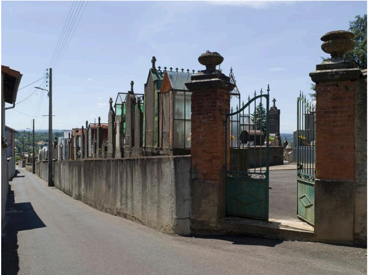
La rue longeant le cimetière des Limandons, dans sa partie médiane (troisième tronçon, entre l'avenue des Etats-Unis et la rue Antonine-Planche).
