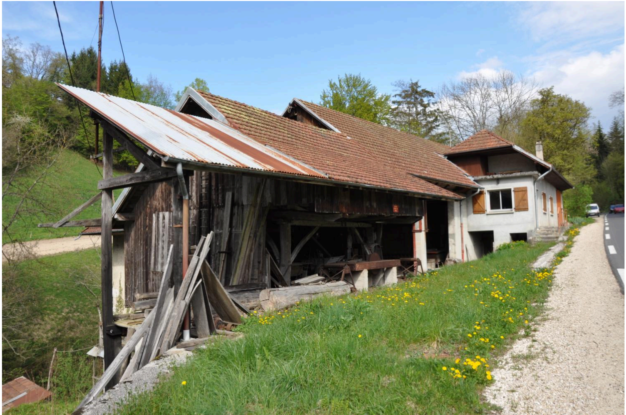
Vue générale de la scierie Millioz depuis la route D 911.
