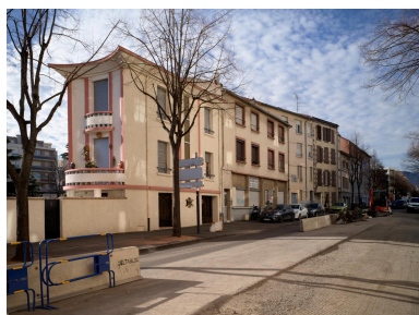
Elévation latérale et façade vues depuis le boulevard Phot. Christian Parisey IVR84_20246300376NUC4A
