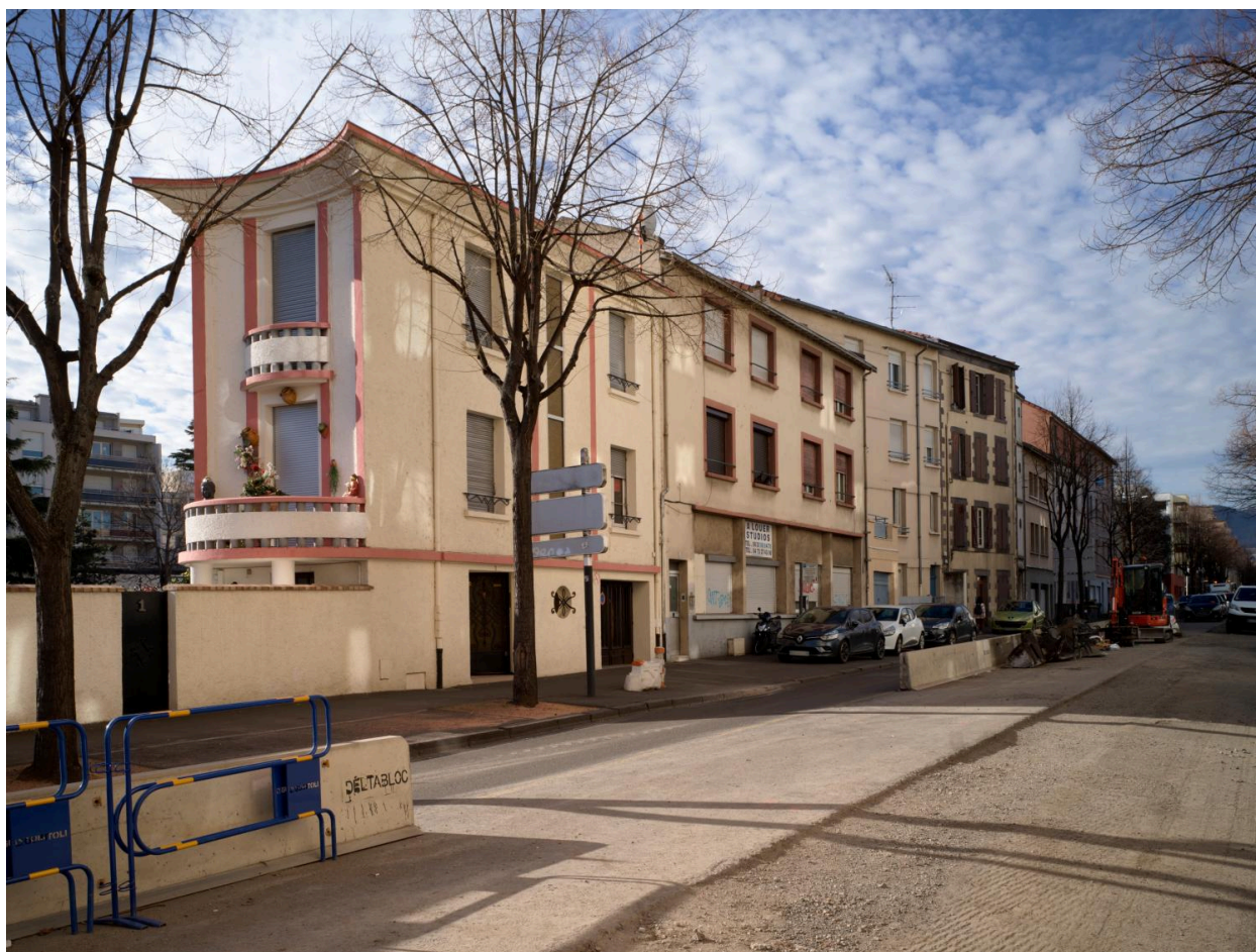
Elévation latérale et façade vues depuis le boulevard
