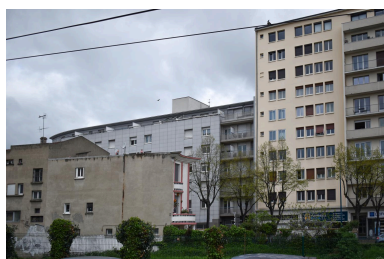
Boulevard Cote Blatin, vue depuis la voie ferrée. A droite, l'arrière du n°1. Phot. Félicie Fougère IVR84_20246300905NUCA
