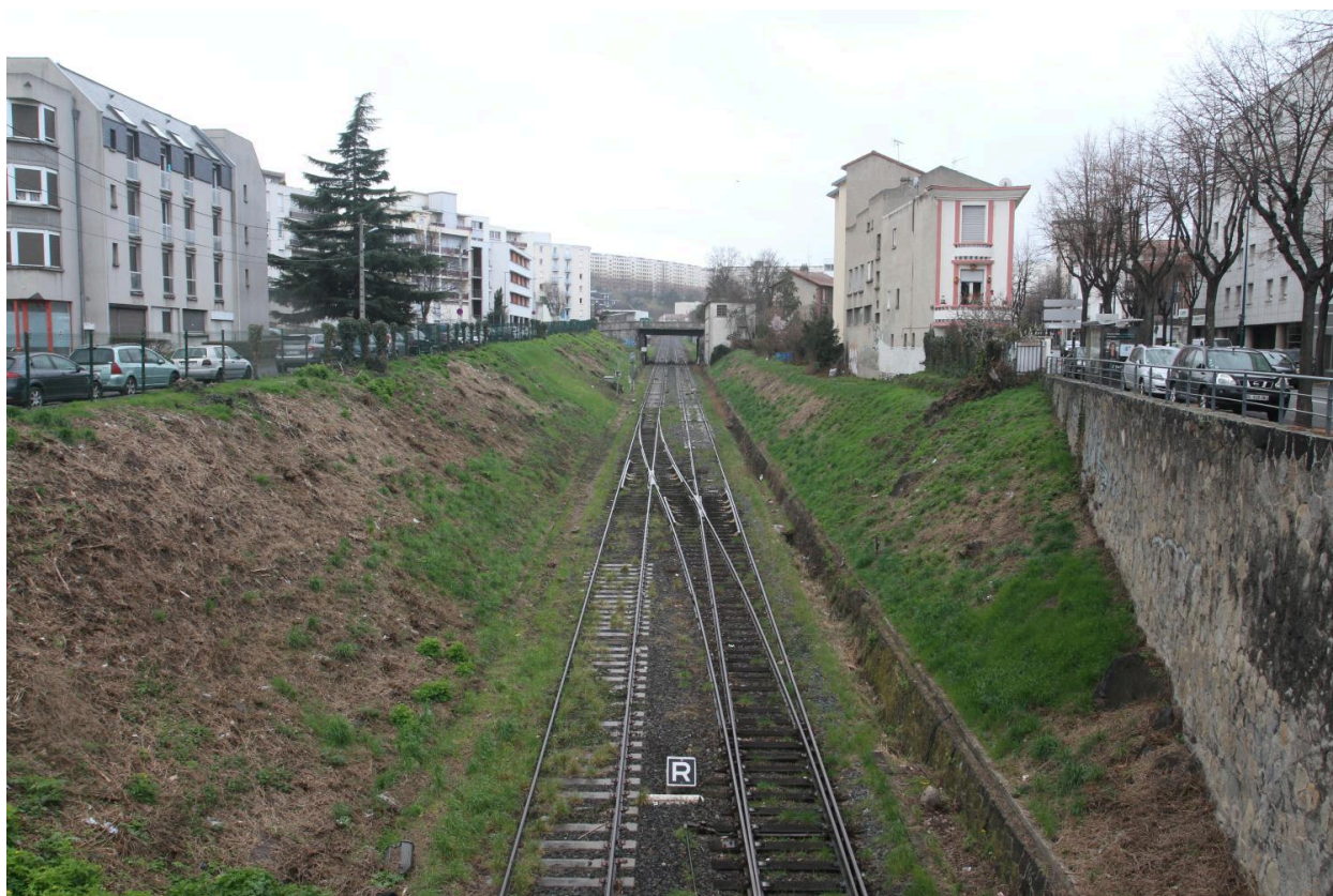
Vue depuis le pont de chemin de fer
