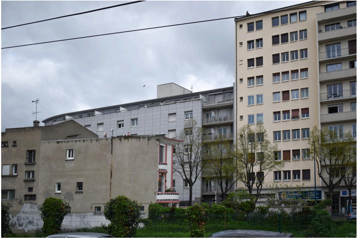
Boulevard Cote Blatin, vue depuis la voie ferrée. A droite, l'arrière du n°1.
