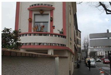
Détail de l'élévation latérale au boulevard Phot. François-Nicolas L'Hardy IVR84_20246301016NUCA
