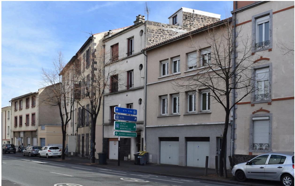
Façades sur le boulevard Cote-Blatin
