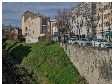
Vue depuis le pont de chemin de fer Phot. Christian Parisey IVR84_20246300374NUC4A
