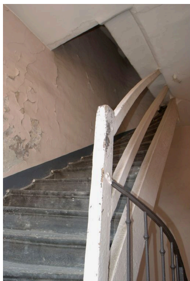
Vue de la dernière volée de l'escalier Phot. Catherine Guégan IVR82_20086903098NUCA
