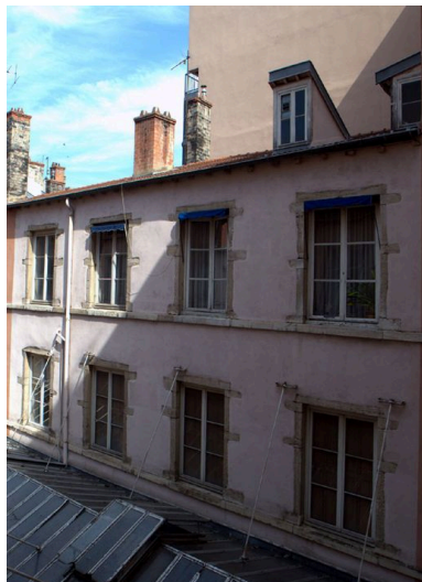
Vue de l'élévation antérieure depuis le sud-est Phot. Catherine Guégan IVR82_20086903096NUCA
