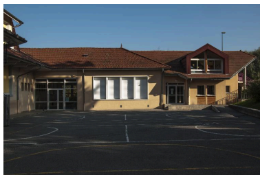
Cour, restaurant scolaire et garderie Phot. Denys Harreau IVR82_20147301265NUCA
