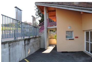
Escalier pont du porche d'entrée de la garderie Phot. Denys Harreau IVR82_20147301281NUCA
