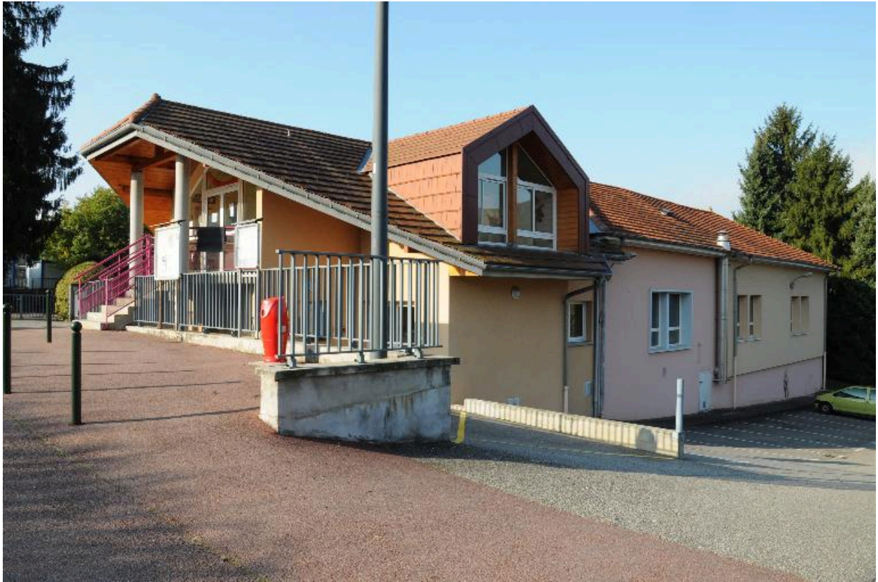
Entrée de la garderie et façades nord du restaurant scolaire
