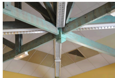
Détail de la charpente du restaurant scolaire Phot. Denys Harreau IVR82_20147301272NUCA
