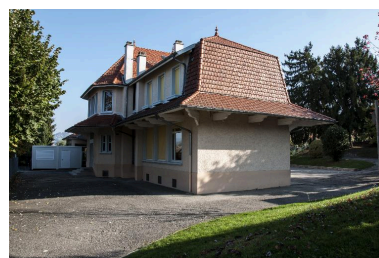
Façades latérale et postérieure Phot. Denys Harreau IVR82_20147301267NUCA
