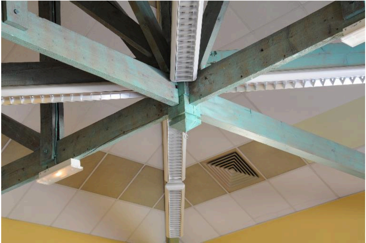
Détail de la charpente du restaurant scolaire
