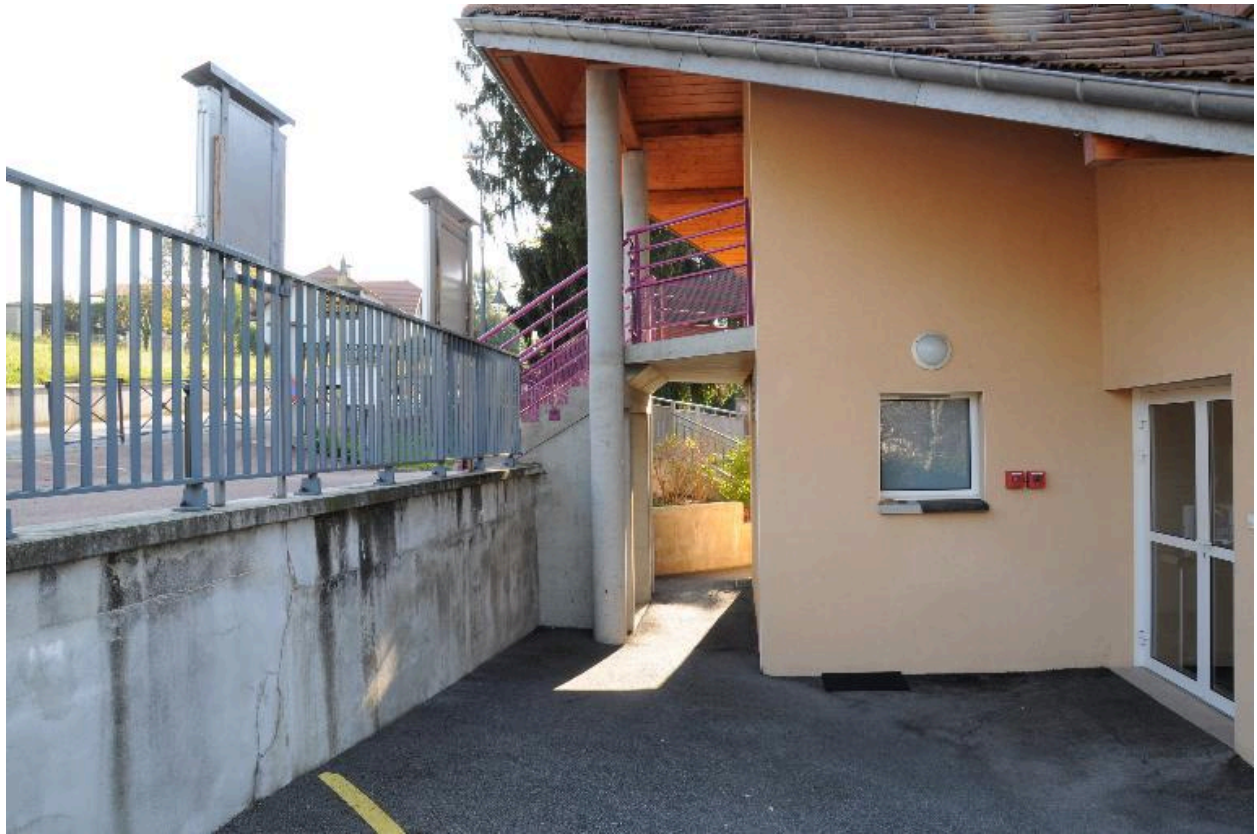
Escalier pont du porche d'entrée de la garderie
