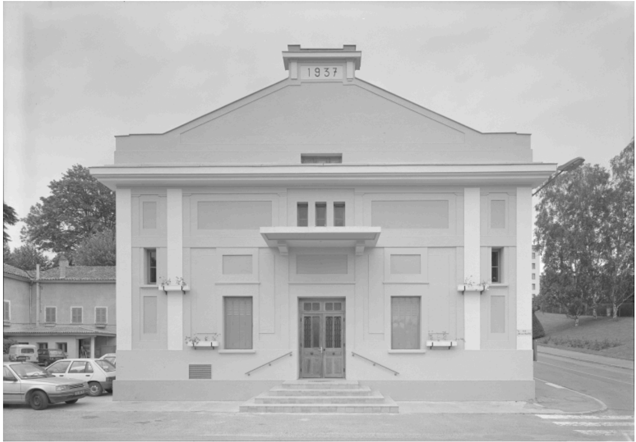
Salle des fêtes (ancien cuvage), façade.
