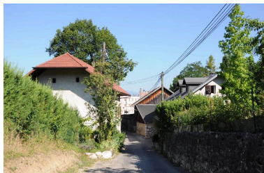
Vue d'ensemble: à droite l'ancienne grange Phot. Denys Harreau IVR82_20137300813NUCA
