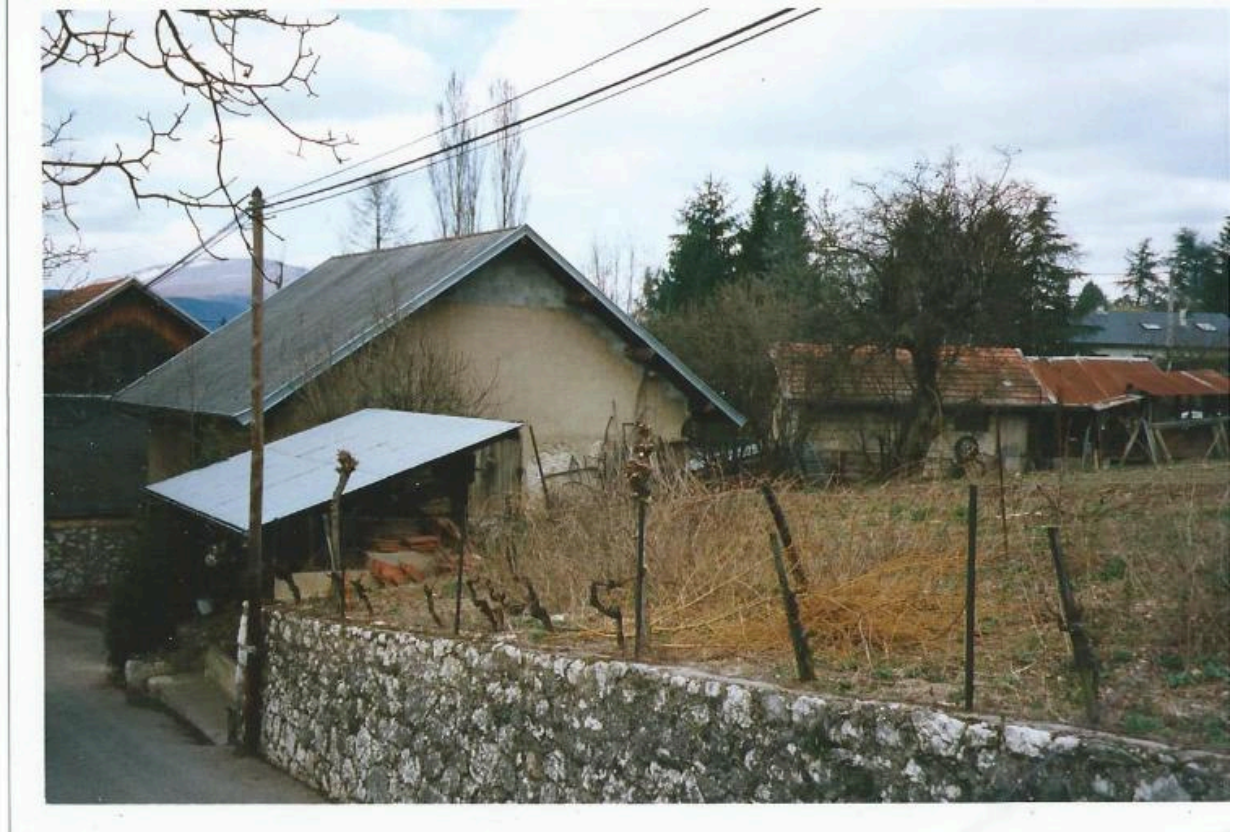
Vue d'ensemble avant transformation, 1998
