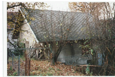
Pignon sud et façade sur jardin de la grange, avant transformation, 1998 Repro. Denys Harreau IVR82_20137300817NUCB
