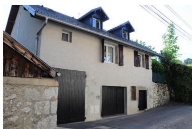
Façade sur rue Phot. Denys Harreau IVR82_20137300812NUCA
