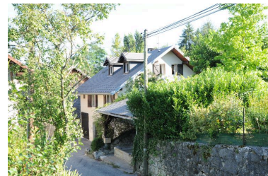
Vue d'ensemble Phot. Denys Harreau IVR82_20137300811NUCA
