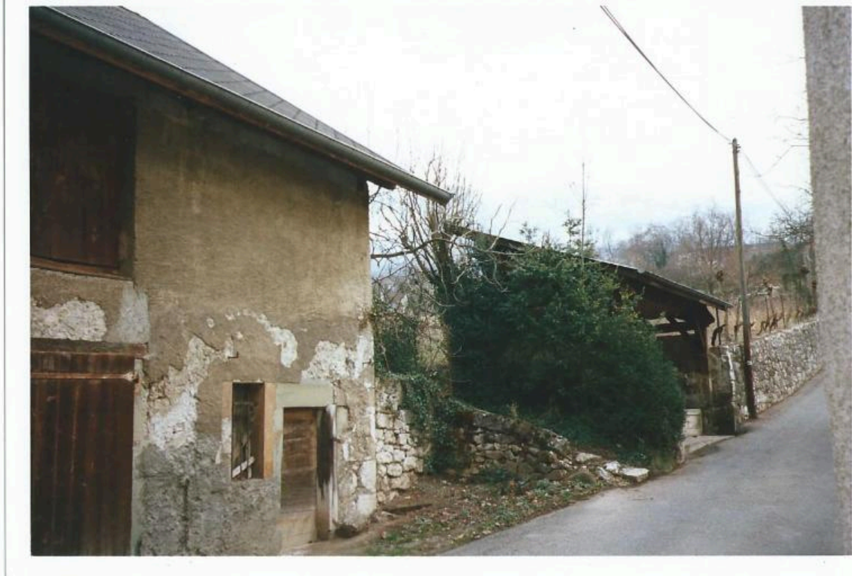
Grange et lavoir vus depuis la rue, avant tranformation, 1998
