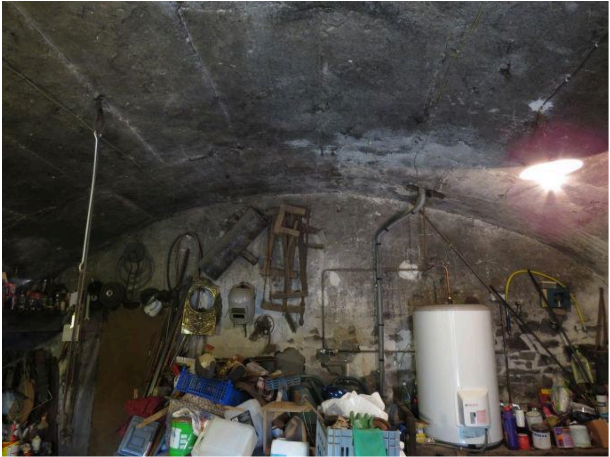
Vue intérieure : local voûté en rez-de-chaussée
