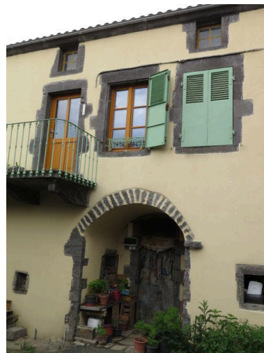
Vue partielle : façade maison Phot. Bruno Decrock IVR84_20216300146NUCA
