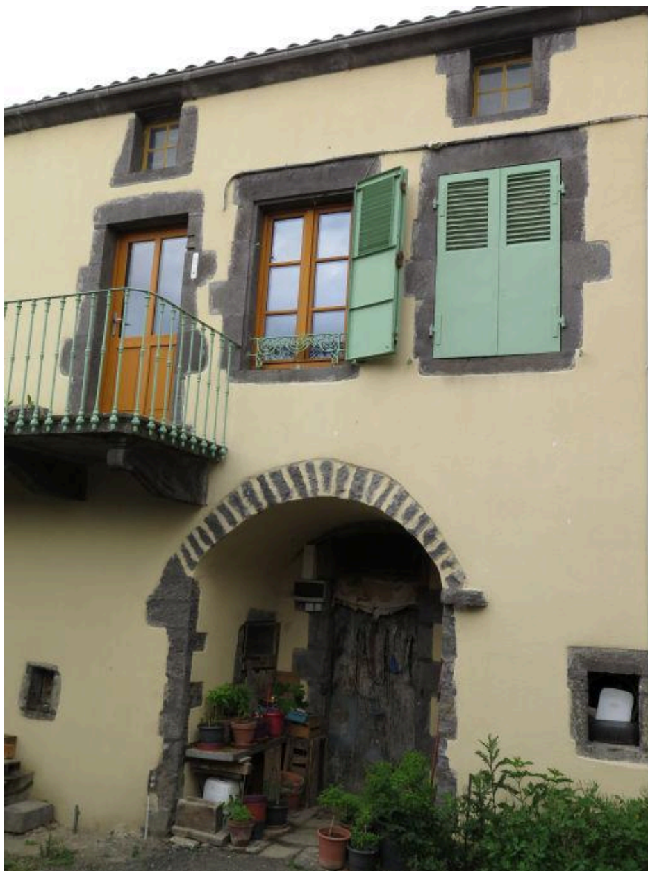
Vue partielle : façade maison
