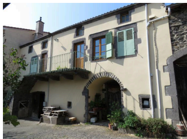
Vue générale : façade maison Phot. Bruno Decrock IVR84_20216300144NUCA
