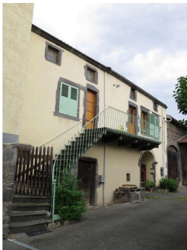
Vue générale : façade maison Phot. Bruno Decrock IVR84_20216300145NUCA
