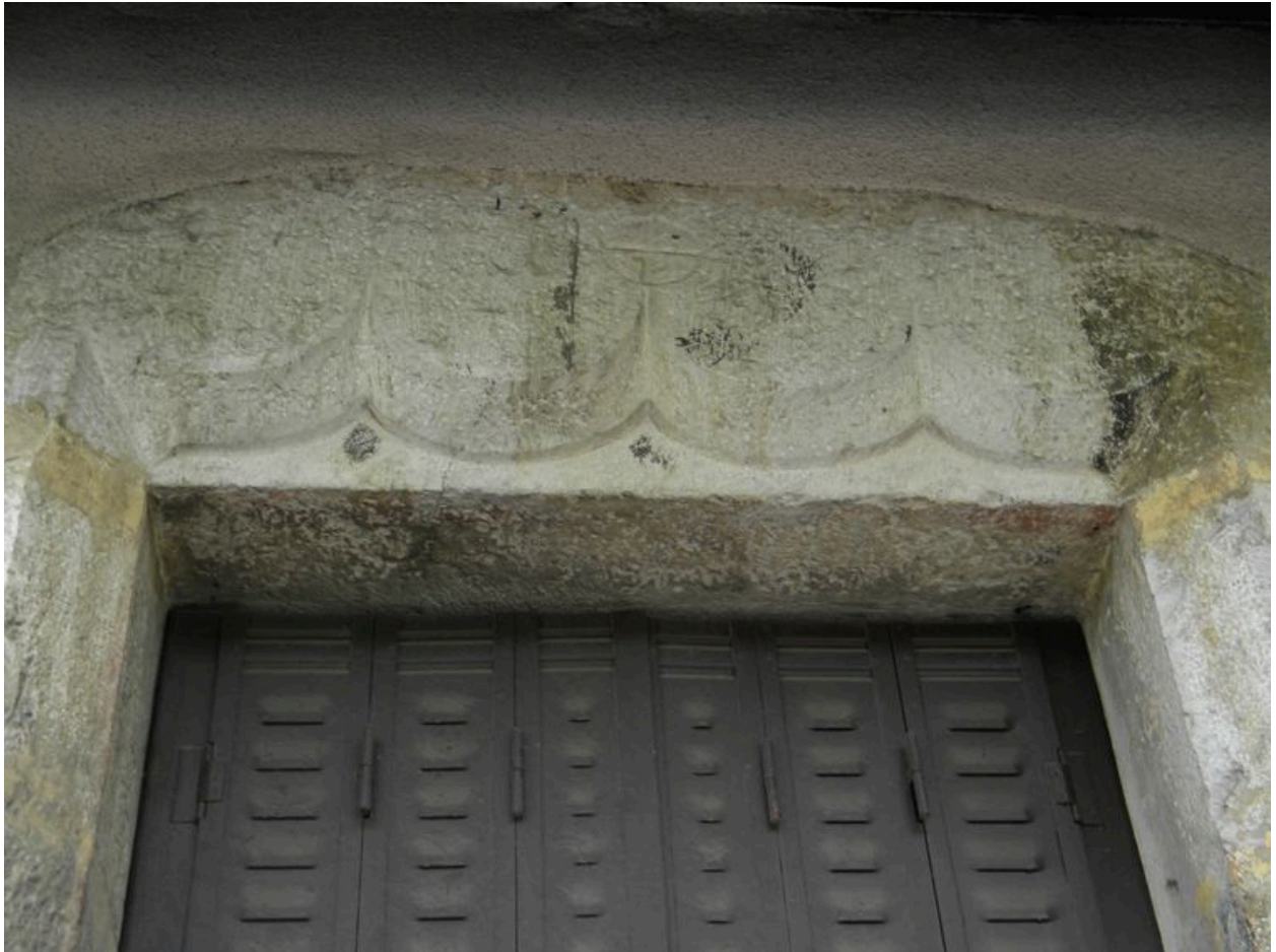
Vue du linteau à triple accolade en façade est.
