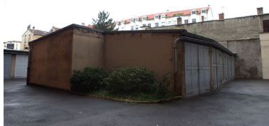
Vue d'ensemble des garages dans la cour Phot. Maryannick Chalabi IVR82_20096901234NUCA
