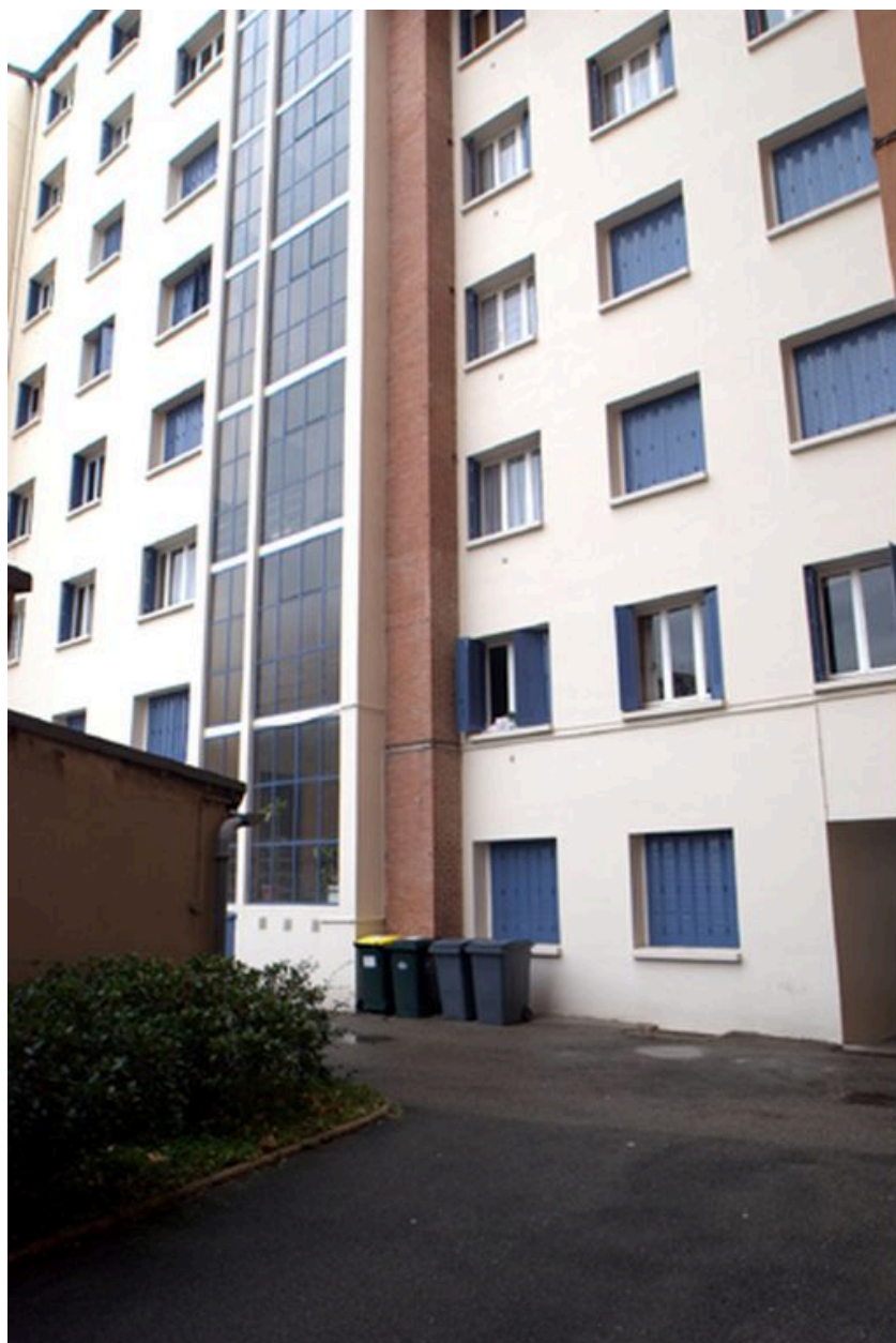
Elévation postérieure. La cage d'escalier demi-hors-oeuvre vitrée
