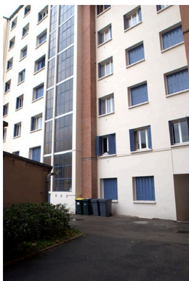
Elévation postérieure. La cage d'escalier demi-hors-oeuvre vitrée
