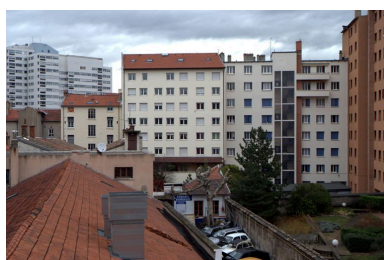
Elévation postérieure depuis le sud Phot. Maryannick Chalabi IVR82_20096901230NUCA
