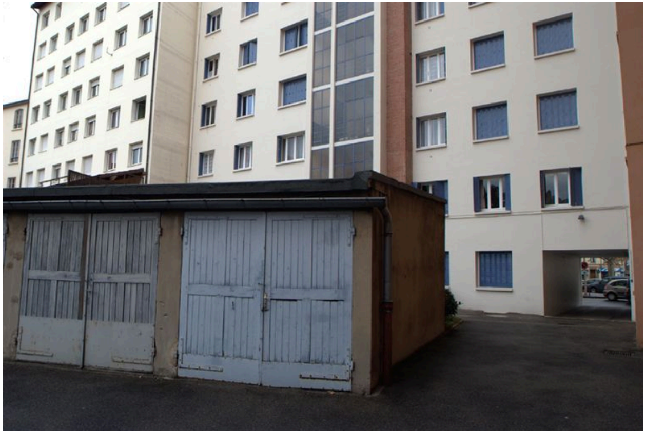
Élévation postérieure. Le passage couvert entre la cour et la rue
