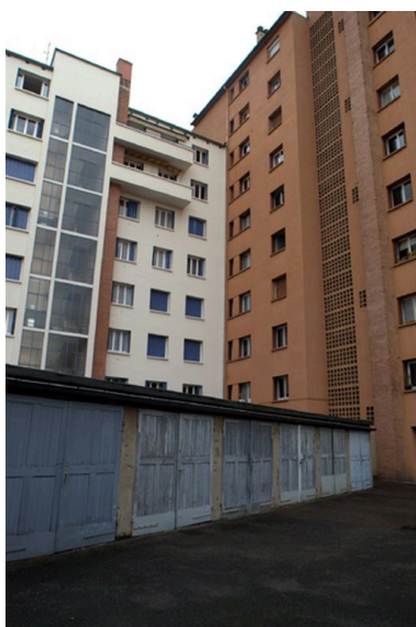
Elévation postérieure. L'accroche du bâtiment avec l'immeuble rue Garibaldi Phot. Maryannick Chalabi IVR82_20096901231NUCA
