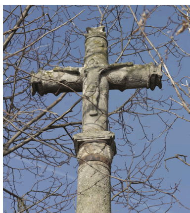
Détail du croisillon. Phot. Eric Dessert IVR82_20064200421NUCA
