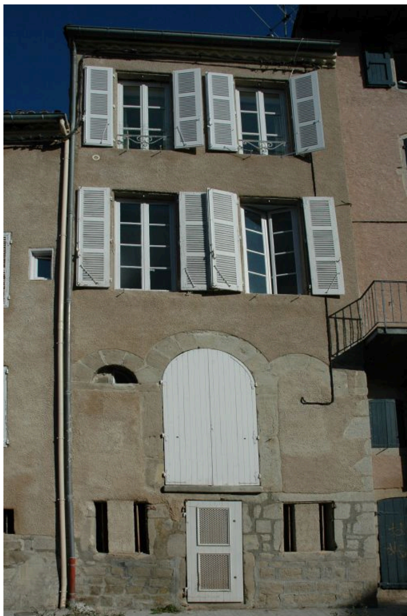
Elévation postérieure sur le quai du Vizézy.
