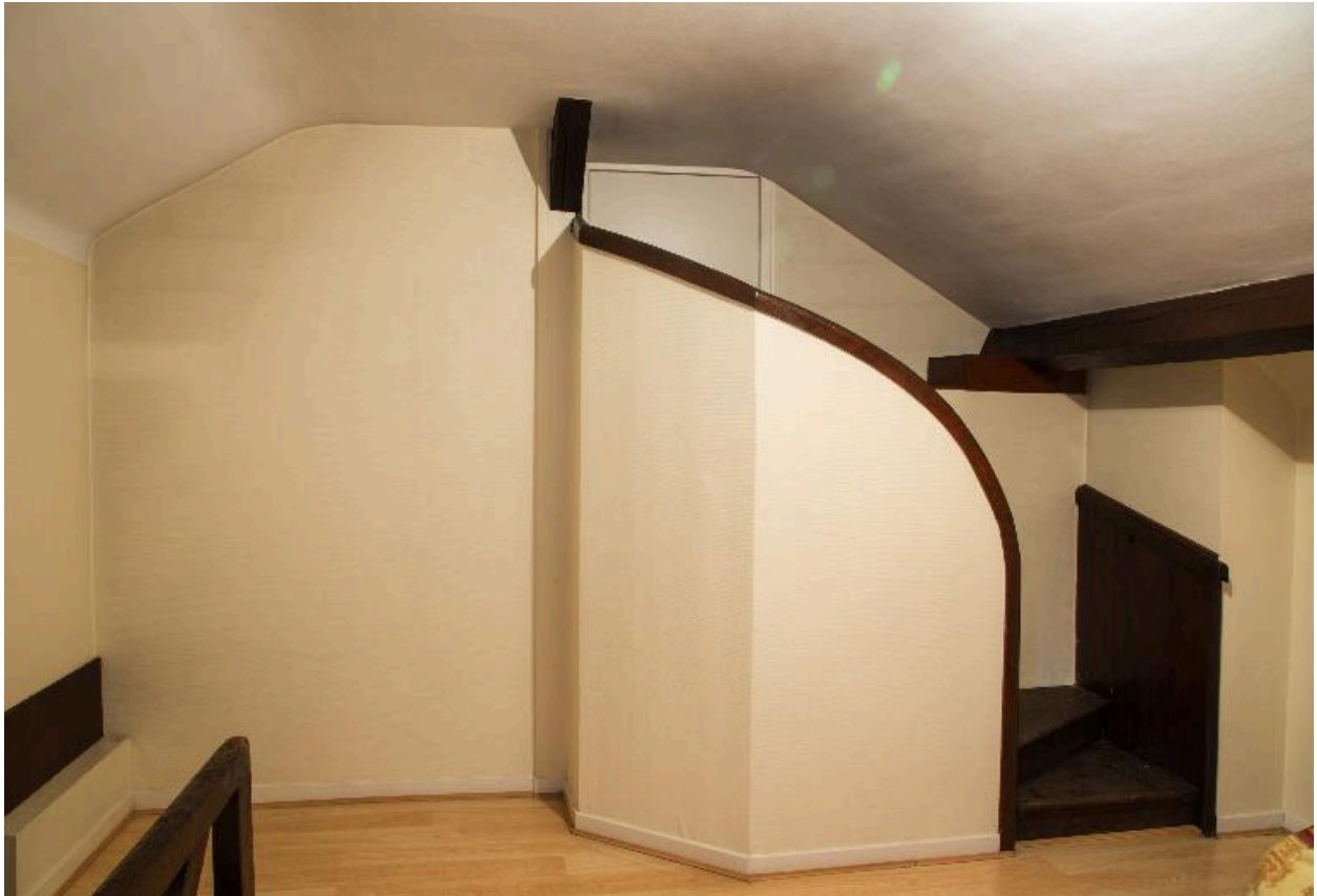
Escalier intérieur menant aux combles.
