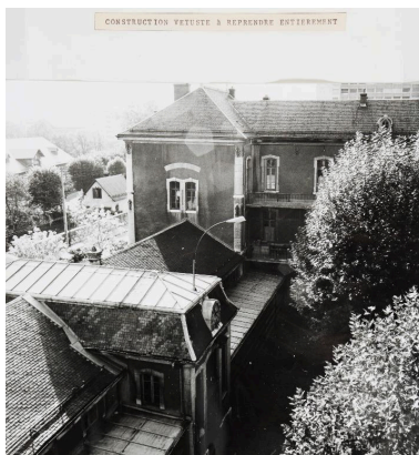
Combles, 1976. Repro. Pascal Lemaître, Autr. auteur inconnu IVR82_20147401603NUCAB
