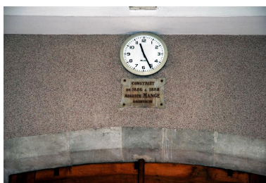
Vestibule, plaque commémorative de la construction du lycée, 1886 Phot. Catherine Guégan IVR82_20167400501NUCA
