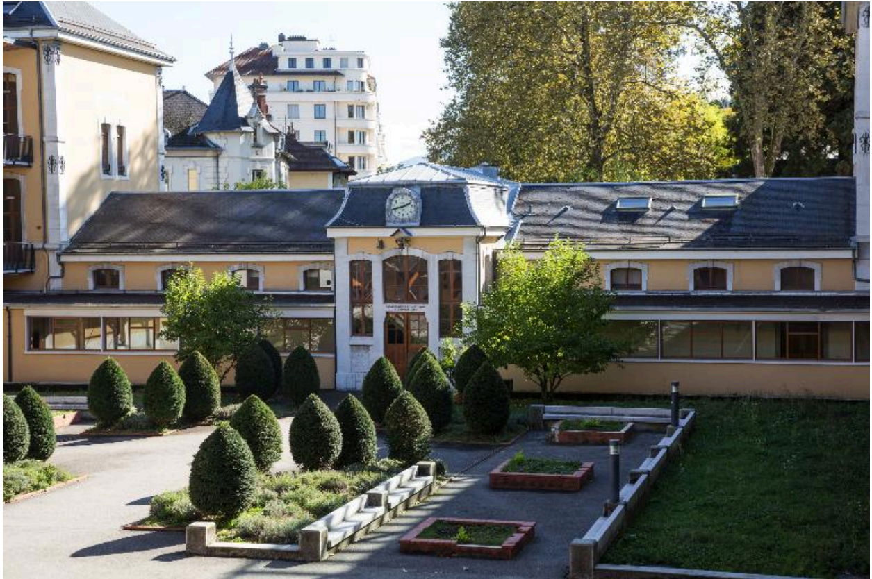
Façade sur cour, vue de trois-quart.
