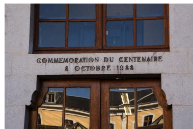
Façade sur cour, inscription commémorative. Phot. Pascal Lemaître IVR82_20147401635NUCA
