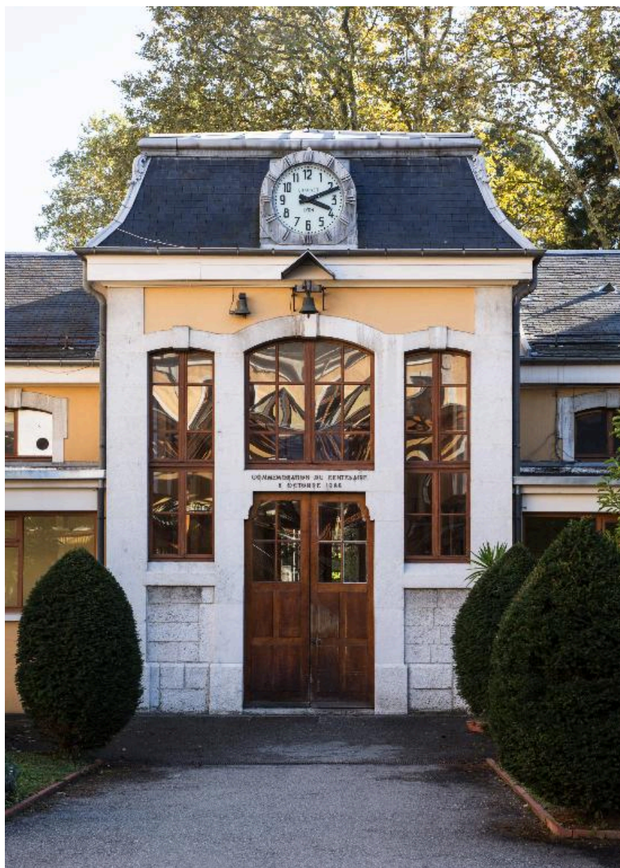
Porte d'accès, façade sur cour.
