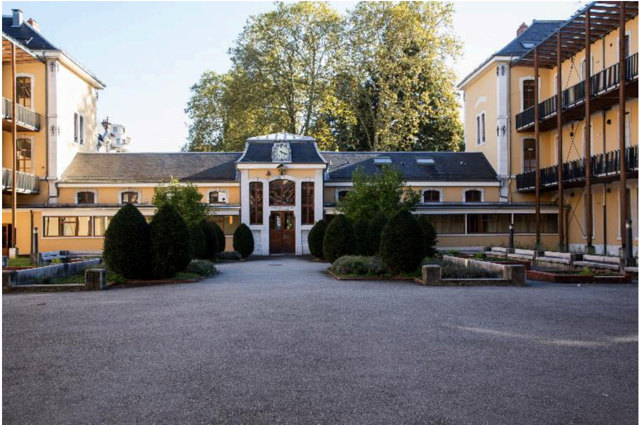
Façade sur cour.
