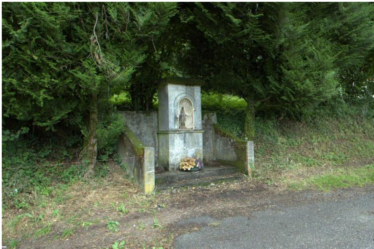
Vue générale de l'oratoire dans son environnement.
