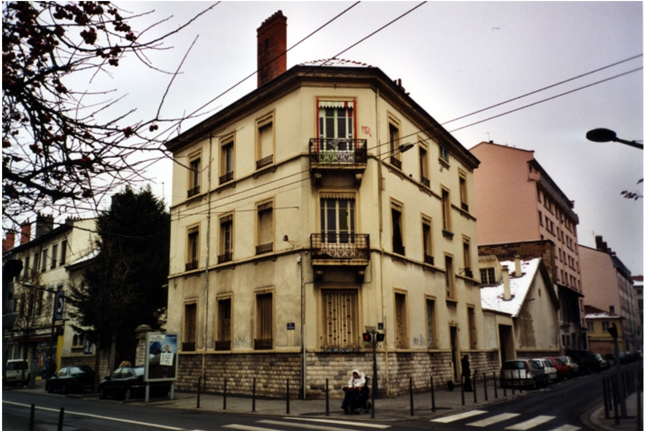
Vue générale nord-est
