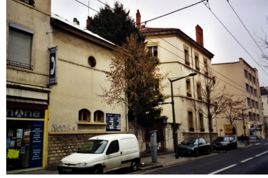
Vue façades est, en alignement sur la rue de Bourgogne Phot. Nadine Halitim-Dubois IVR82_20066900171NUCA
