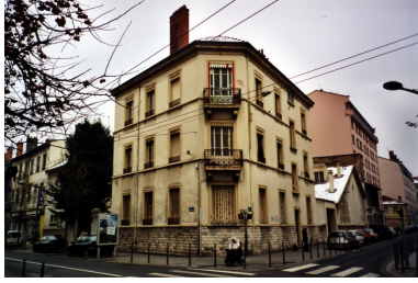
Vue générale nord-est Phot. Nadine Halitim-Dubois IVR82_20066900172NUCA
