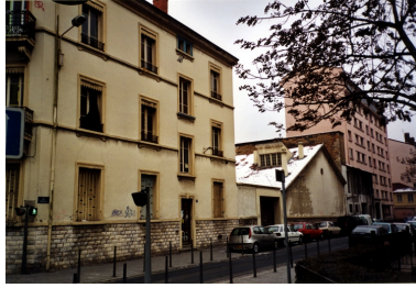
Façades nord en alignement sur la rue Nérard Phot. Nadine Halitim-Dubois IVR82_20066900173NUCA
