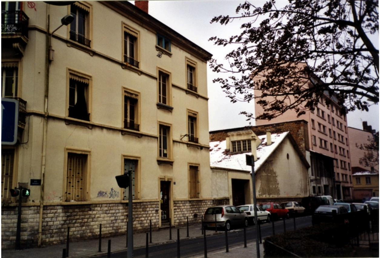
Façades nord en alignement sur la rue Nérard
