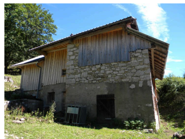
Vue de la façade nord-ouest. Phot. Jérôme Daviet IVR82_20127400686NUCA
