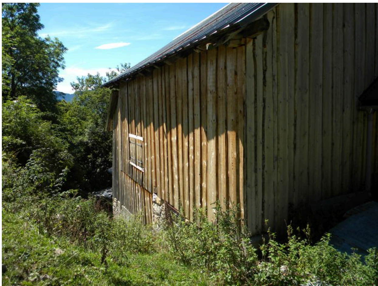
Vue de la façade sud-est.
