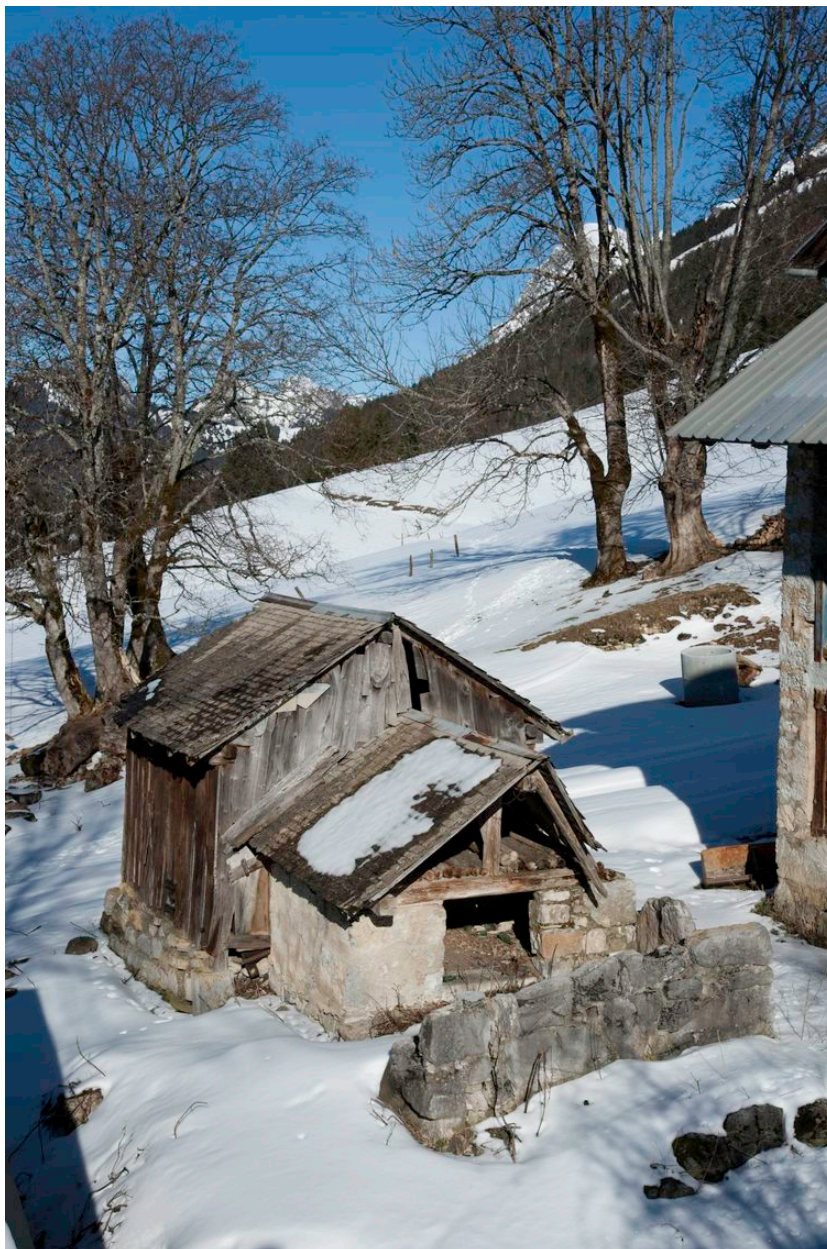
Vue générale de la dépendance.
