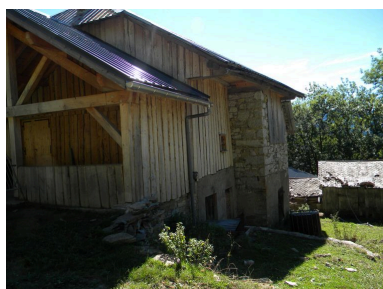
Vue de la façade arrière. Phot. Jérôme Daviet IVR82_20127400687NUCA
