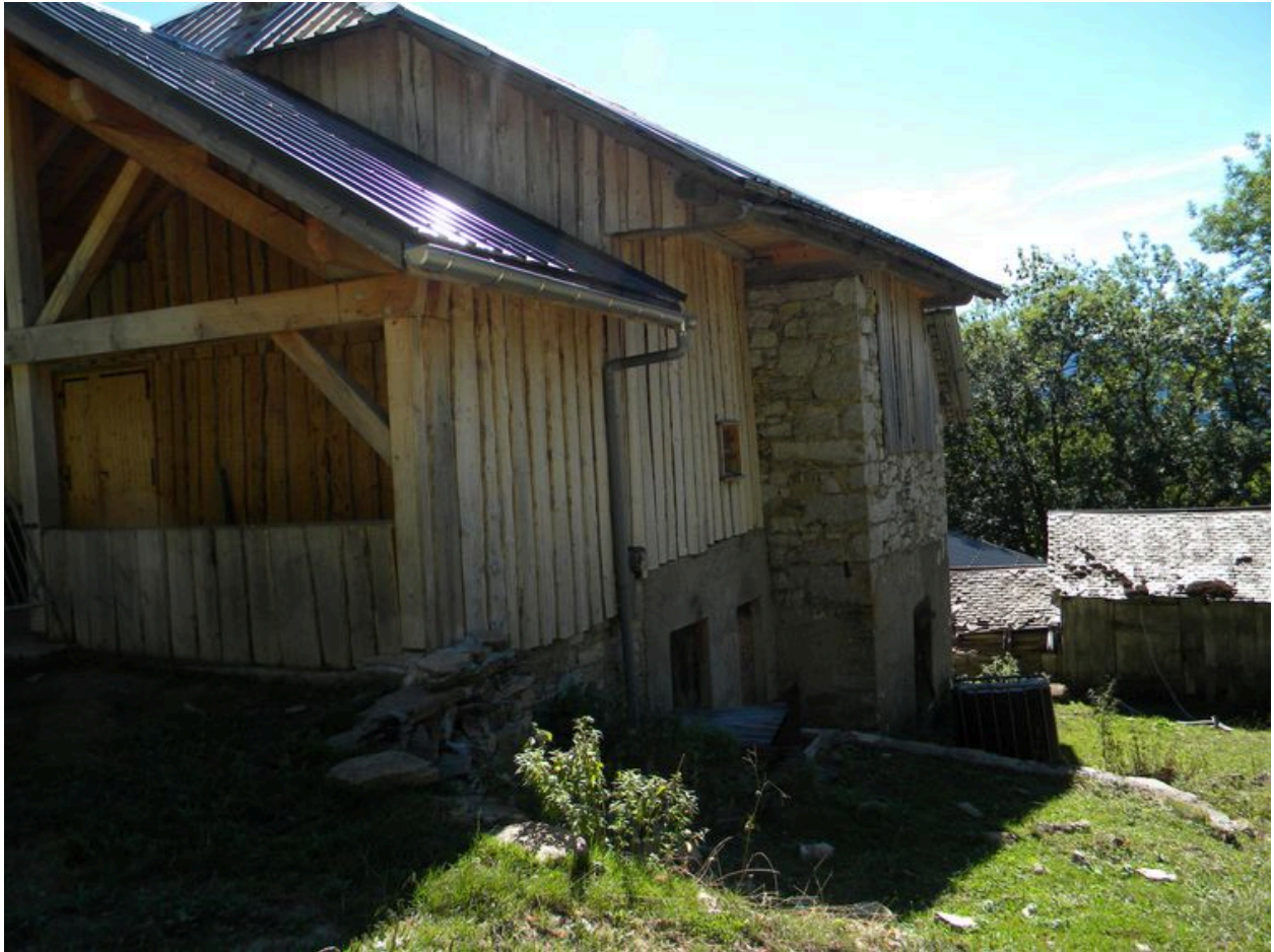
Vue de la façade arrière.
