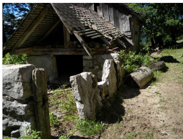
Vue de la partie en pierre de la dépendance avec un mur en pierre levée au premier plan. Phot. Jérôme Daviet IVR82_20127400694NUCA
