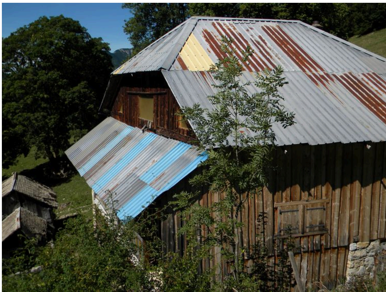
Vue des partie hautes de la façade est.
