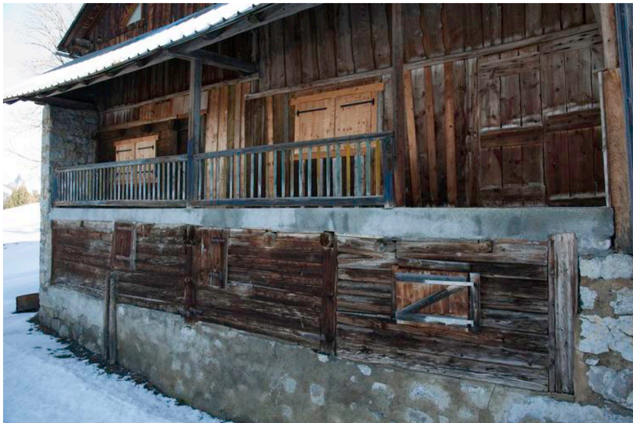
Vue de la façade principale avec la galerie couverte en façade.
