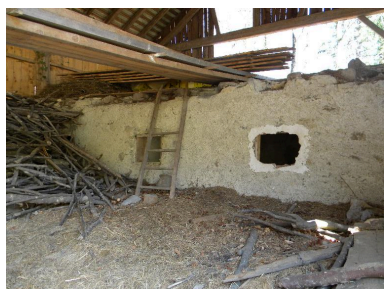
Vue des vestiges des trapes pour passer le foin dans l'étable dans une grange étable isolée (2008 F6 749). Phot. Jérôme Daviet IVR82_20137401112NUCA
