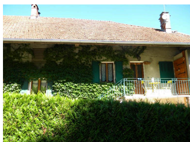
Vue de la façade d'une ancienne ferme (2008 F4 603). Phot. Jérôme Daviet IVR82_20137401115NUCA
