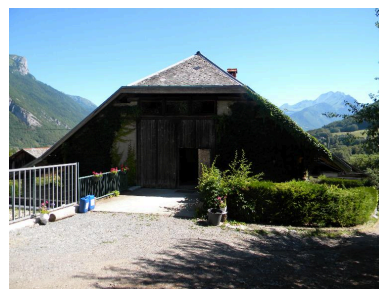
Vue du pignon sud-ouest avec accès au fenil d'une ancienne ferme (2008 F4 603) Phot. Jérôme Daviet IVR82_20137401114NUCA
