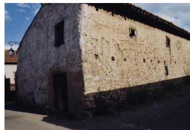
Vue arrière depuis la rue. Phot. Caroline Guibaud IVR82_20134200973ZE
