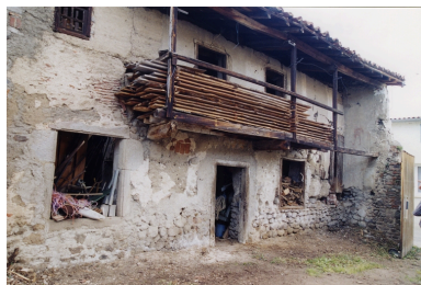
Vue d'ensemble depuis la cour. Phot. Caroline Guibaud IVR82_20134200971ZE
