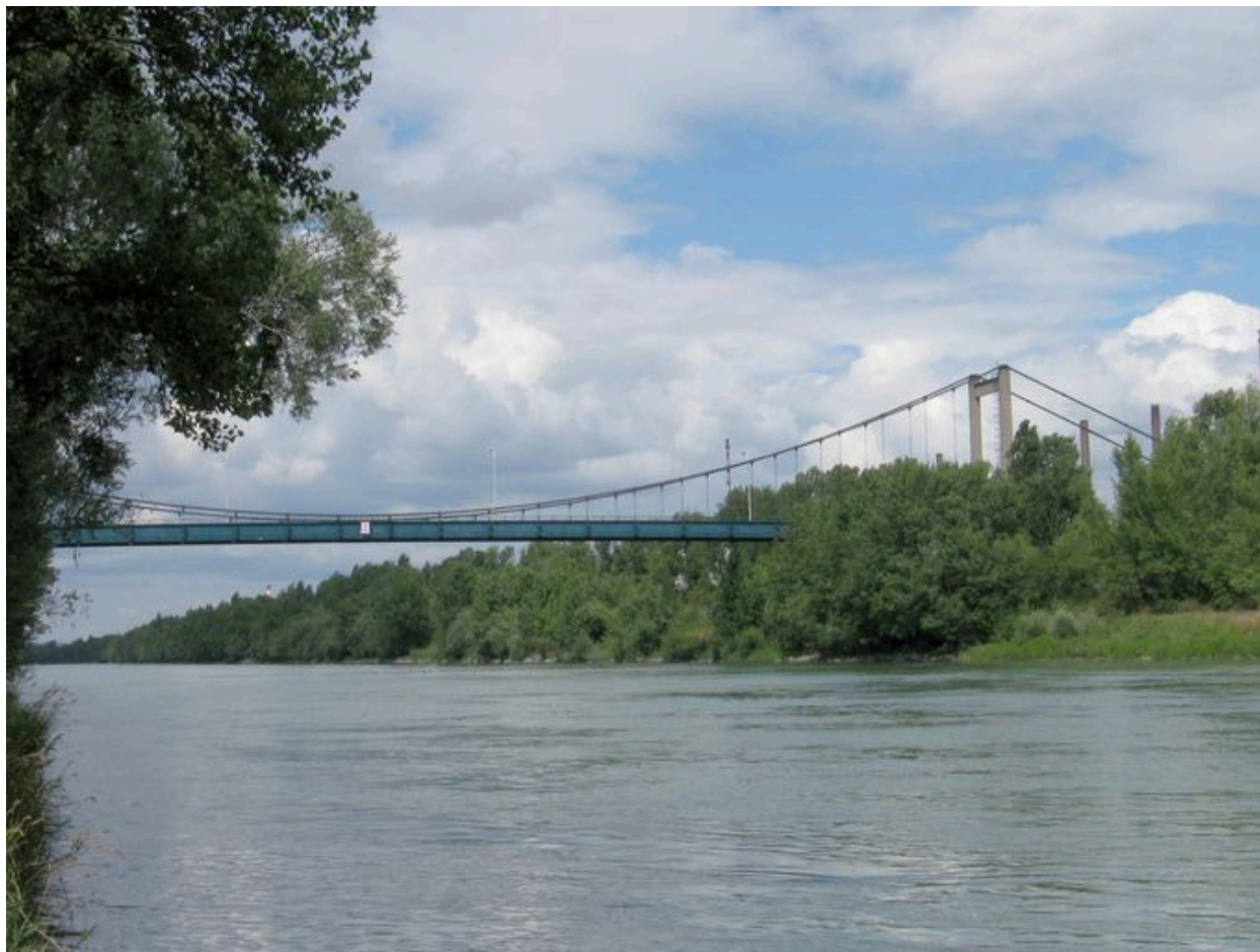
Vue générale, face aval (depuis la rive droite)
