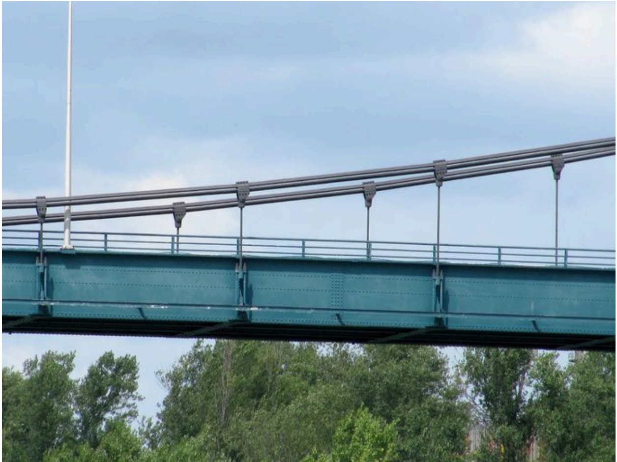
Tablier, parapet, suspente et câble de retenue, vue partielle (depuis la rive droite)
