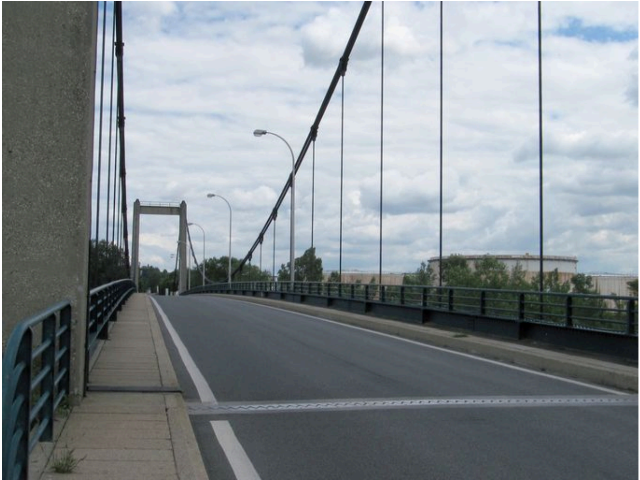
Chaussée (depuis la rive droite)
