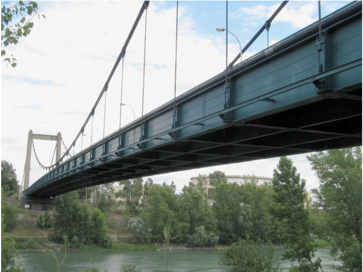
Tablier, face amont (depuis la rive droite)
