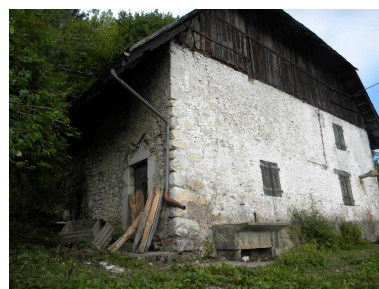
Vue de trois-quarts depuis le sud. Phot. Jérôme Daviet IVR82_20137401189NUCA
