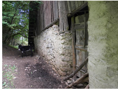
Vue de la façade arrière. Phot. Jérôme Daviet IVR82_20137401191NUCA
