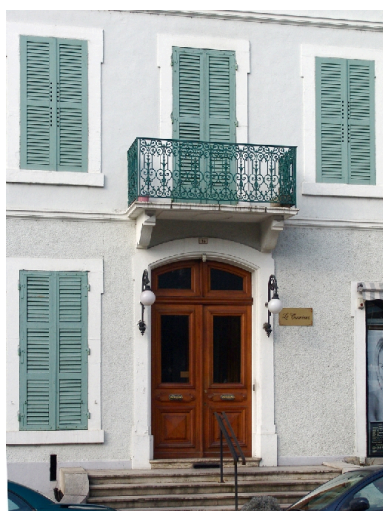
Détail de la porte d'entrée Phot. François Fouger IVR82_20057300313NUCA
