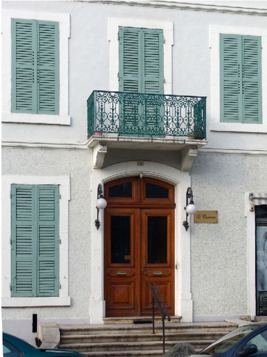
Détail de la porte d'entrée
