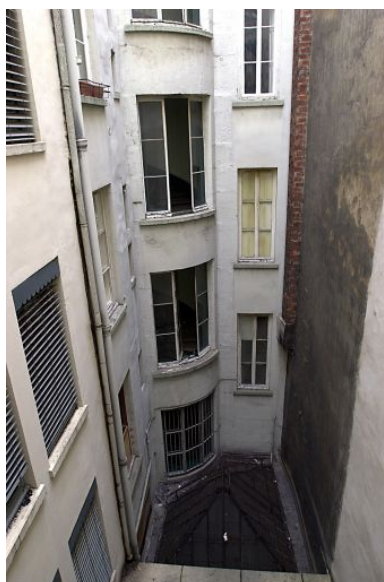
Façade sur cour et cage d'escalier Phot. Bernard Ducouret IVR82_20046900267NUCA
