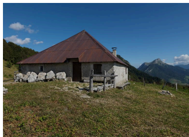
Vue du bâtiment d'habitation. Phot. Thierry Leroy IVR84_20167305808NUCAQ
