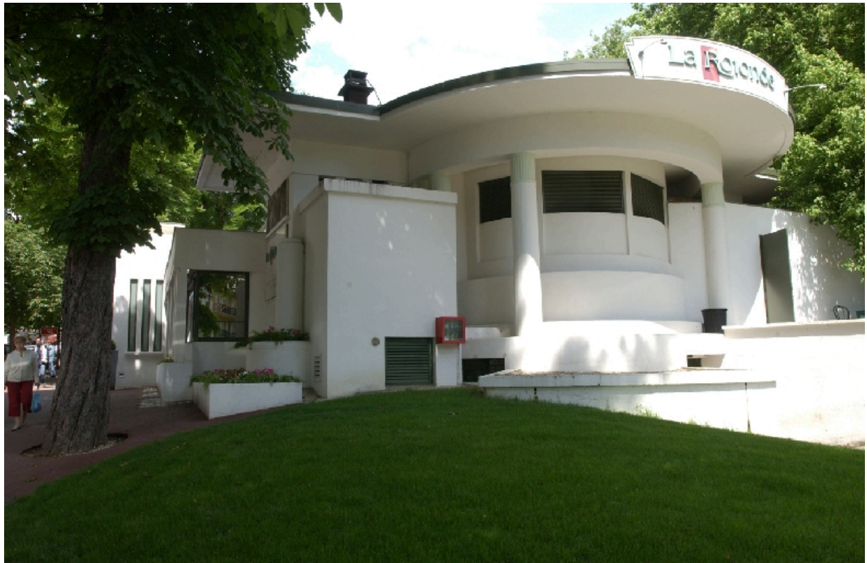
Vue depuis le sud
