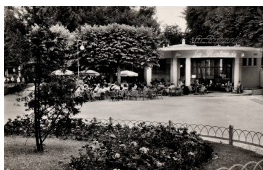
Vue de l'entrée Repro. François Fouger IVR82_20067300147NUCB
