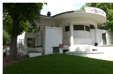
Vue depuis le sud Phot. François Fouger IVR82_20067300655NUCA
