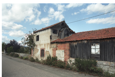
Vue d'ensemble depuis l'est du pigeonnier. Phot. Thierry Monnet IVR82_20064200004ZE
