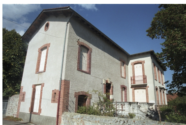
Détail de la montée d'escalier maçonnée. Phot. Thierry Monnet IVR82_20064200002ZE
