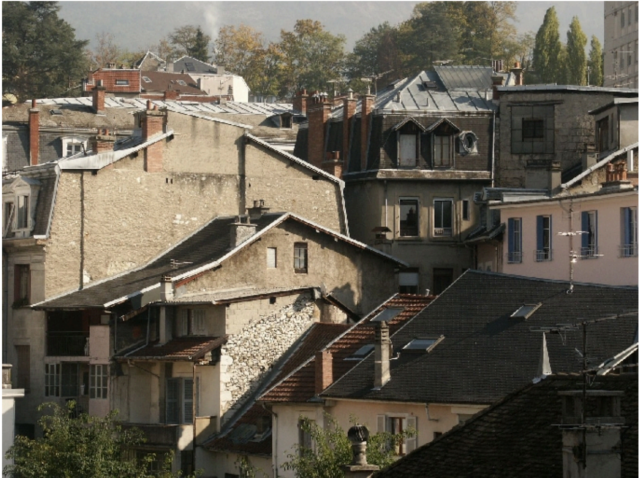
Vue des immeubles sur l'impasse de la Chaudanne et la ruelle du Revet
