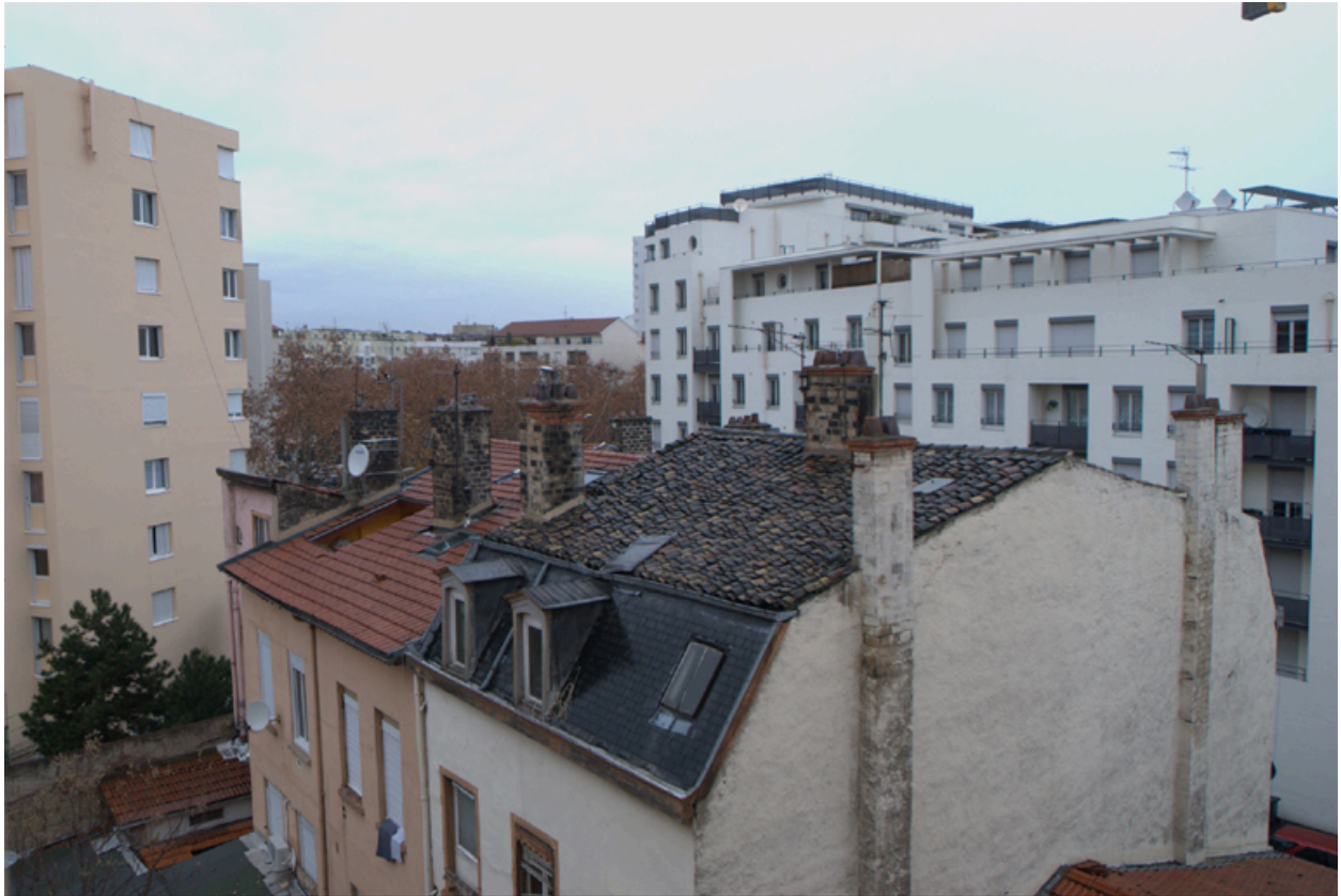
Vue des toits des immeubles 186 et 188-190 grande rue de la Guillotière
