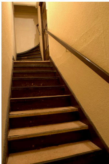
L'escalier en bois vers le 2e étage Phot. Maryannick Chalabi IVR82_20086900826NUCA
