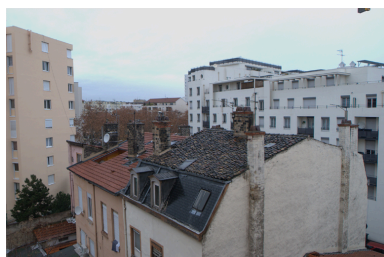
Vue des toits des immeubles 186 et 188-190 grande rue de la Guillotière Phot. Maryannick Chalabi IVR82_20126902433NUCA
