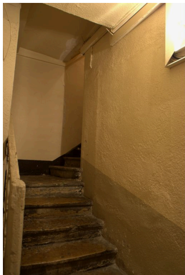
La première volée de l'escalier en pierre Phot. Maryannick Chalabi IVR82_20086900825NUCA
