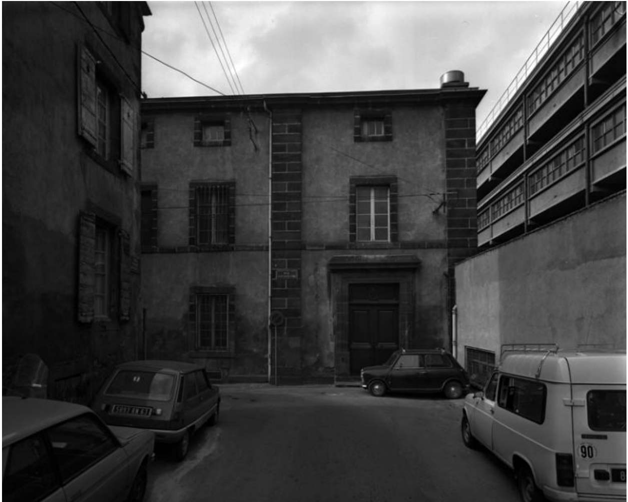
Hôtel-Dieu de Clermont-Ferrand. Le Refuge, la chapelle, élévation nord, extrémité ouest, 1981.
