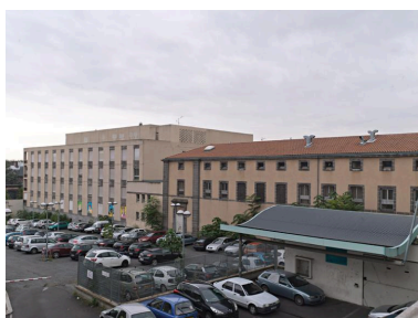
Hôtel-Dieu de Clermont-Ferrand. Le Refuge, façade nord du corps de bâtiment nord qui abritait la chapelle. Phot. Jean-Michel Périn IVR83_20146300807NUC4A
