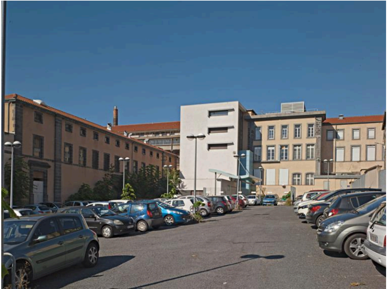
Hôtel-Dieu de Clermont-Ferrand. Le Refuge, façade nord du corps de bâtiment nord vue du nord-est (à gauche de la photographie).
