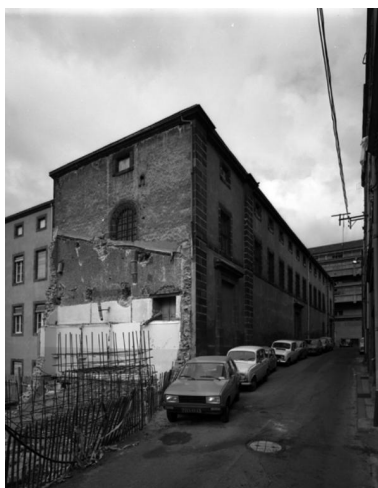
Hôtel-Dieu de Clermont-Ferrand. Le Refuge, la chapelle, vue générale, du nord-est, 1981. Phot. Roger Choplain, Phot. Roland Maston IVR83_19816300512V
