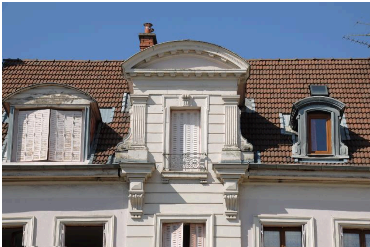
Lucarne-pignon à fronton cintré
