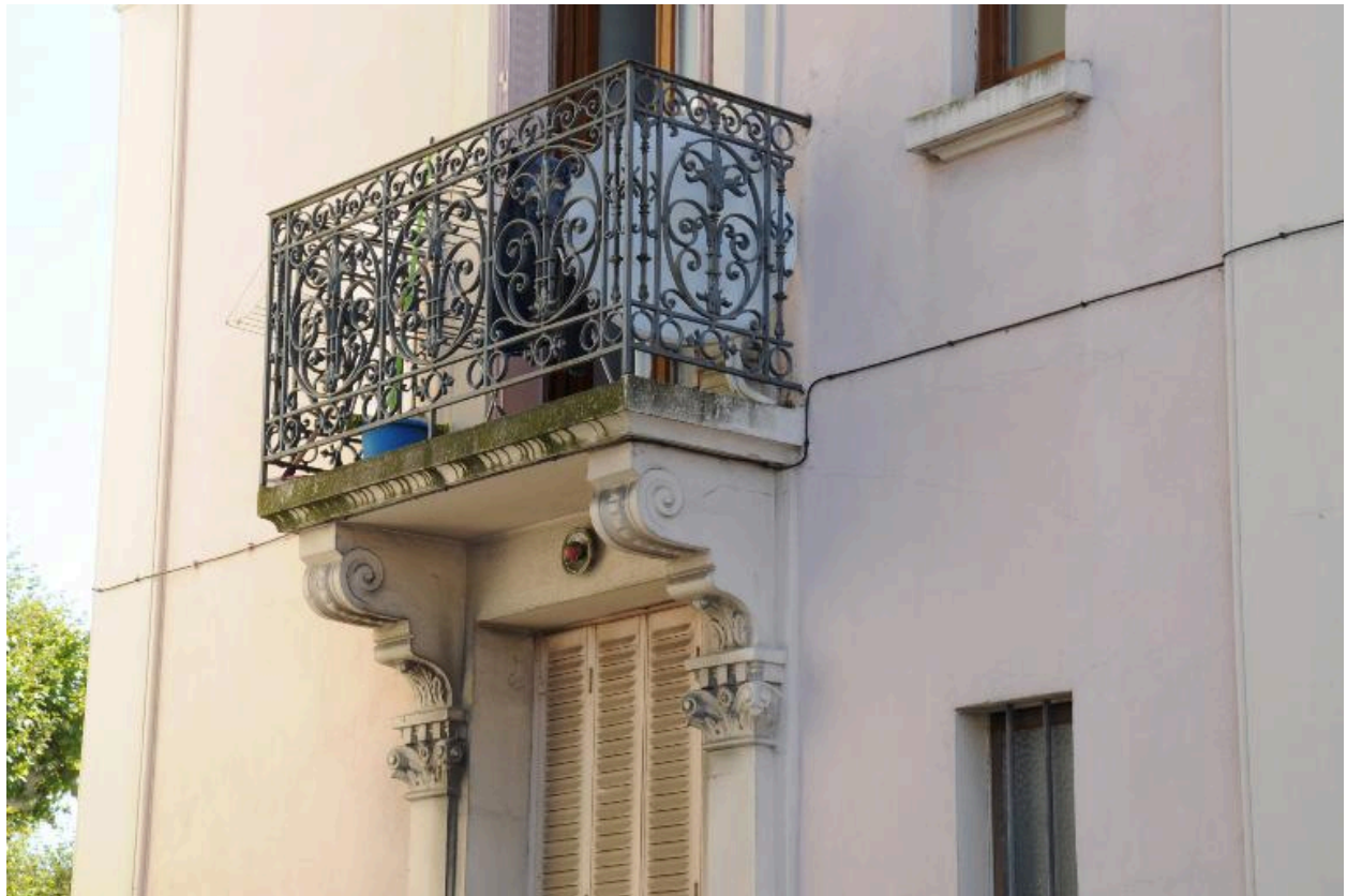
Détail sur le balcon et ses consoles, élévation orientale de l'aile est
