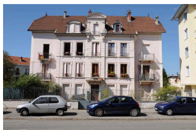
Elévation principale orientée au sud Phot. Denys Harreau IVR82_20147301124NUCA
