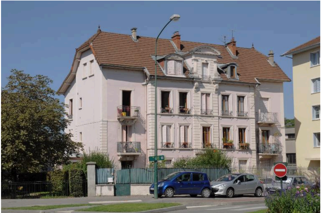
Vue d'ensemble prise depuis le sud-ouest
