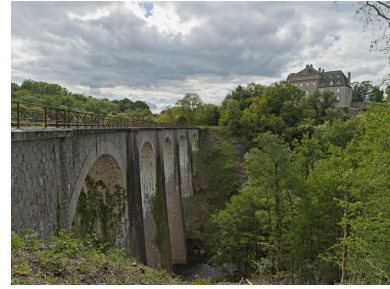
Vue du viaduc ferroviaire de Viescamp, côté amont, au nord. Phot. Jean-Michel Périn IVR83_20151500043NUC4A
