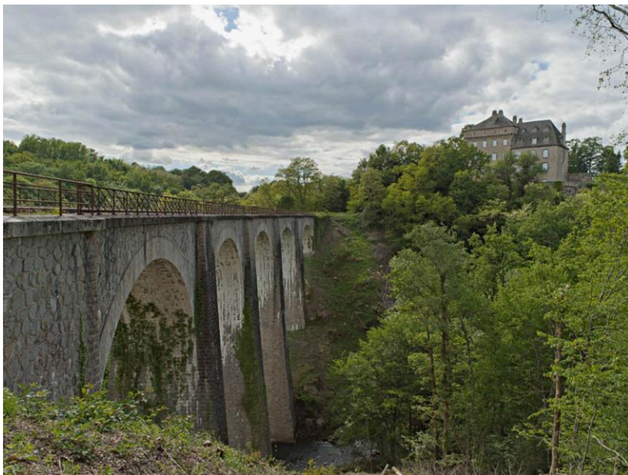
Vue du viaduc ferroviaire de Viescamp, côté amont, au nord.
