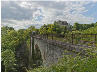
Vue du viaduc ferroviaire de Viescamp, côté aval, au sud. Phot. Jean-Michel Périn IVR83_20151500044NUC4A
