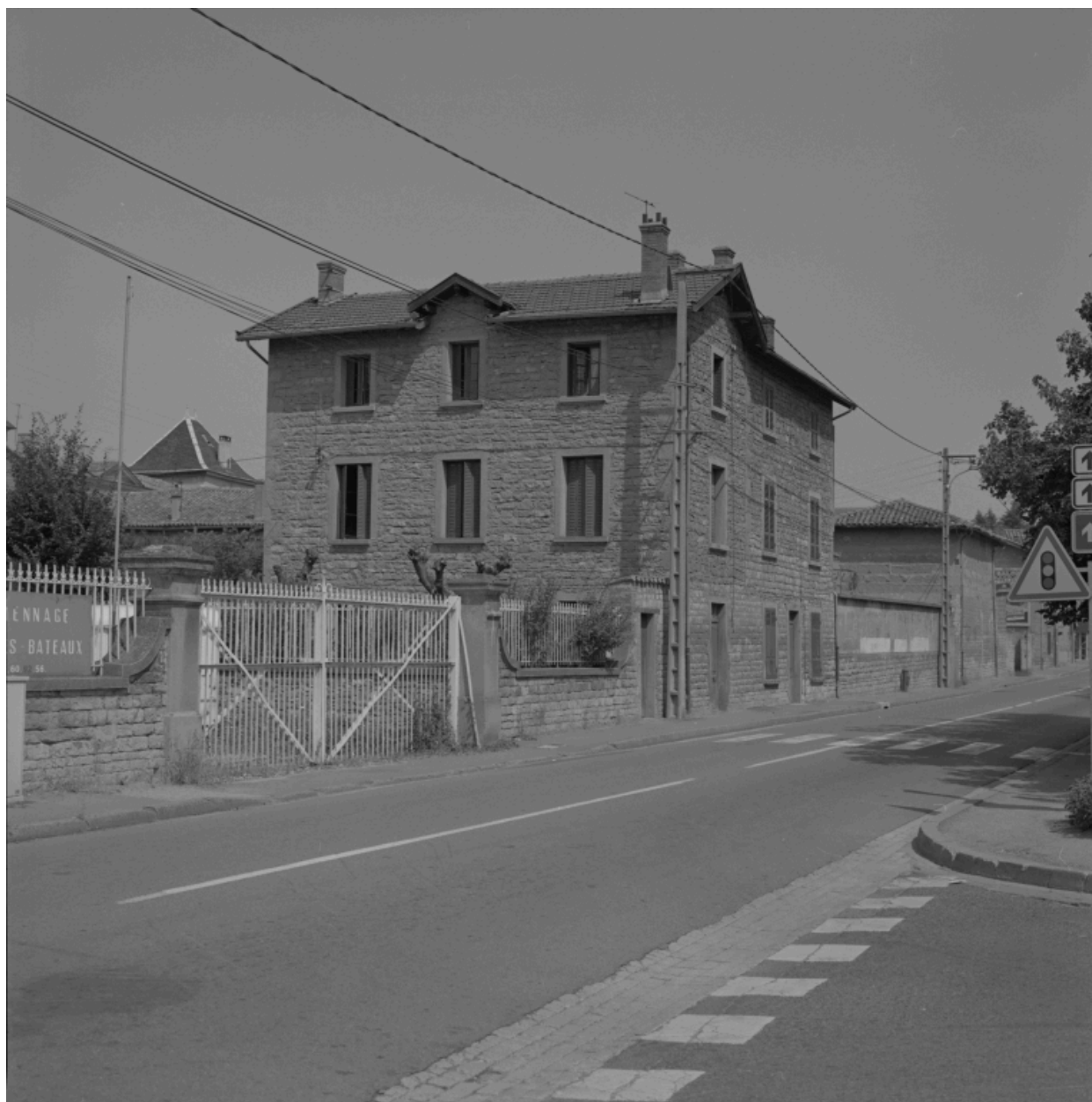
Maison de type V, Jassans-Riottier, 994 et 1006 rue Edouard Herriot : maisons individuelles accolées, construites en 1926-1928.
