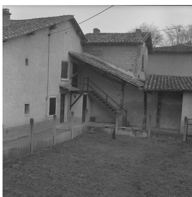
Maison de type I, Frans, chemin du Creuzat, 2e maison : maison rurale en pisé, escalier extérieur dans la cour protégé par un auvent. Phot. Eric Dessert IVR82_19910101061X
