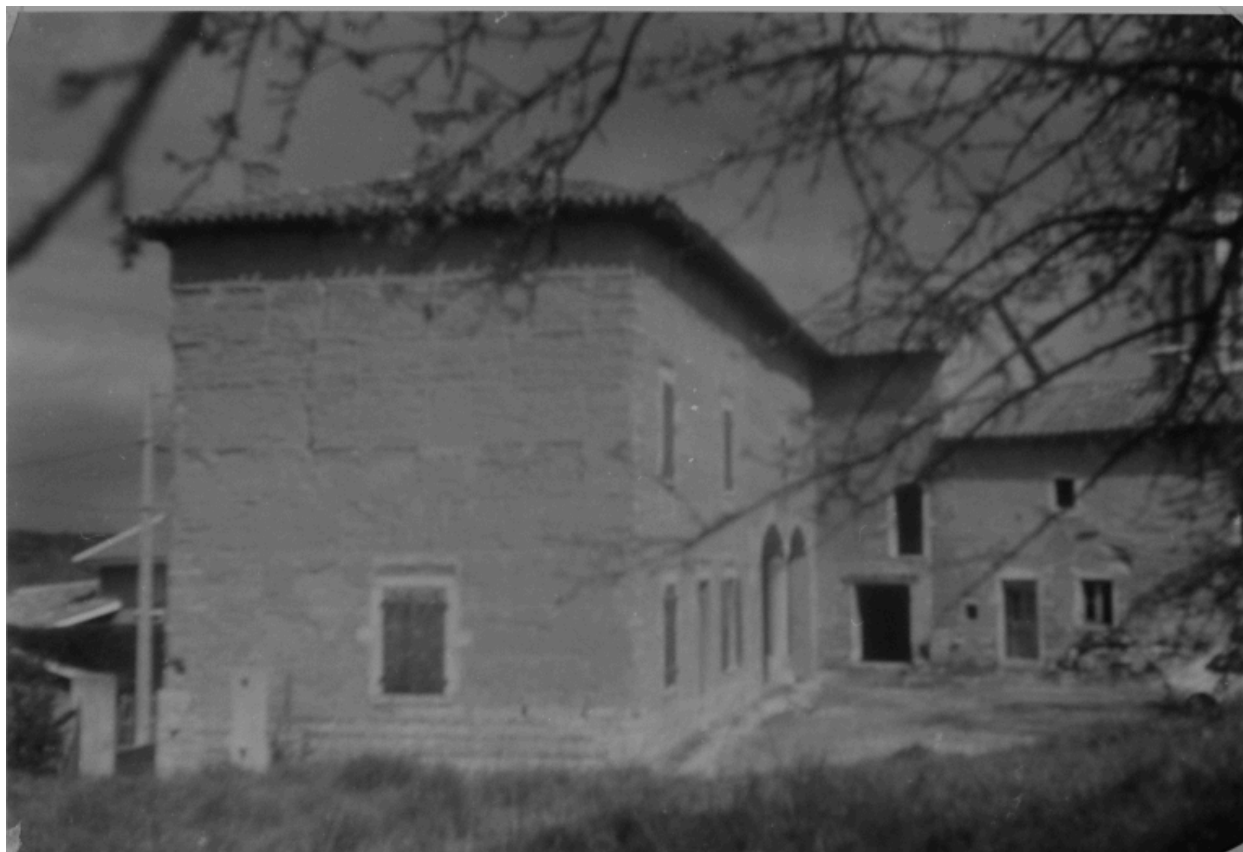
Maison de type VI (maison de maître), Saint-Didier-de-Formans, chemin Charbonnet : vue d'ensemble avant restauration.
