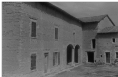
Maison de type VI (maison de maître), Saint-Didier-de-Formans, chemin Charbonnet : porche et logis avant restauration. Repro. Jean-Marie Refflé, Autr. Le Dieudeville (photographe) IVR82_19920100656XB
