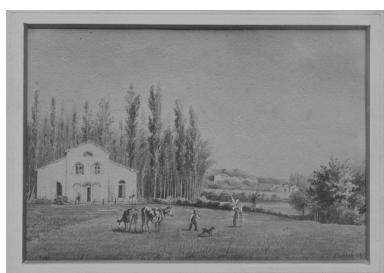
Maison dans la campagne de Trévoux. Aquarelle, par Claudius Dubief, 184[.]. Phot. Eric Dessert IVR82_19890100585X
