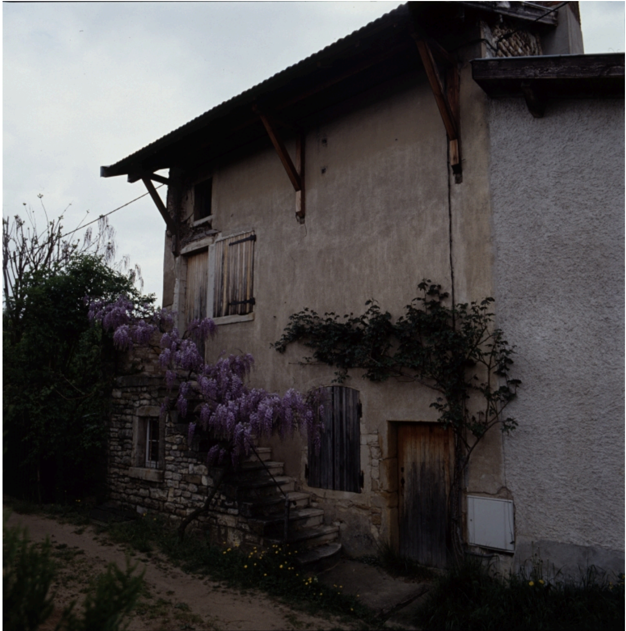
Maison de type I, Saint-Bernard, rue de la Saône : maison rurale en pisé, escalier extérieur couvert par l'avant-toit débordant sur aisseliers.
