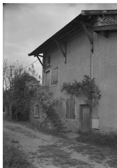
Maison de type I, Saint-Bernard, rue de la Saône : maison rurale en pisé, escalier extérieur couvert par l'avant-toit débordant sur aisseliers. Phot. Jean-Marie Refflé IVR82_19920100391P
