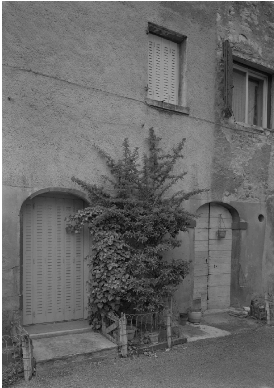
Maison de type IV, Saint-Bernard, 15 rue de la Saône-impasse Antoine Jacquet, élévation sur l'impasse, vue partielle.
