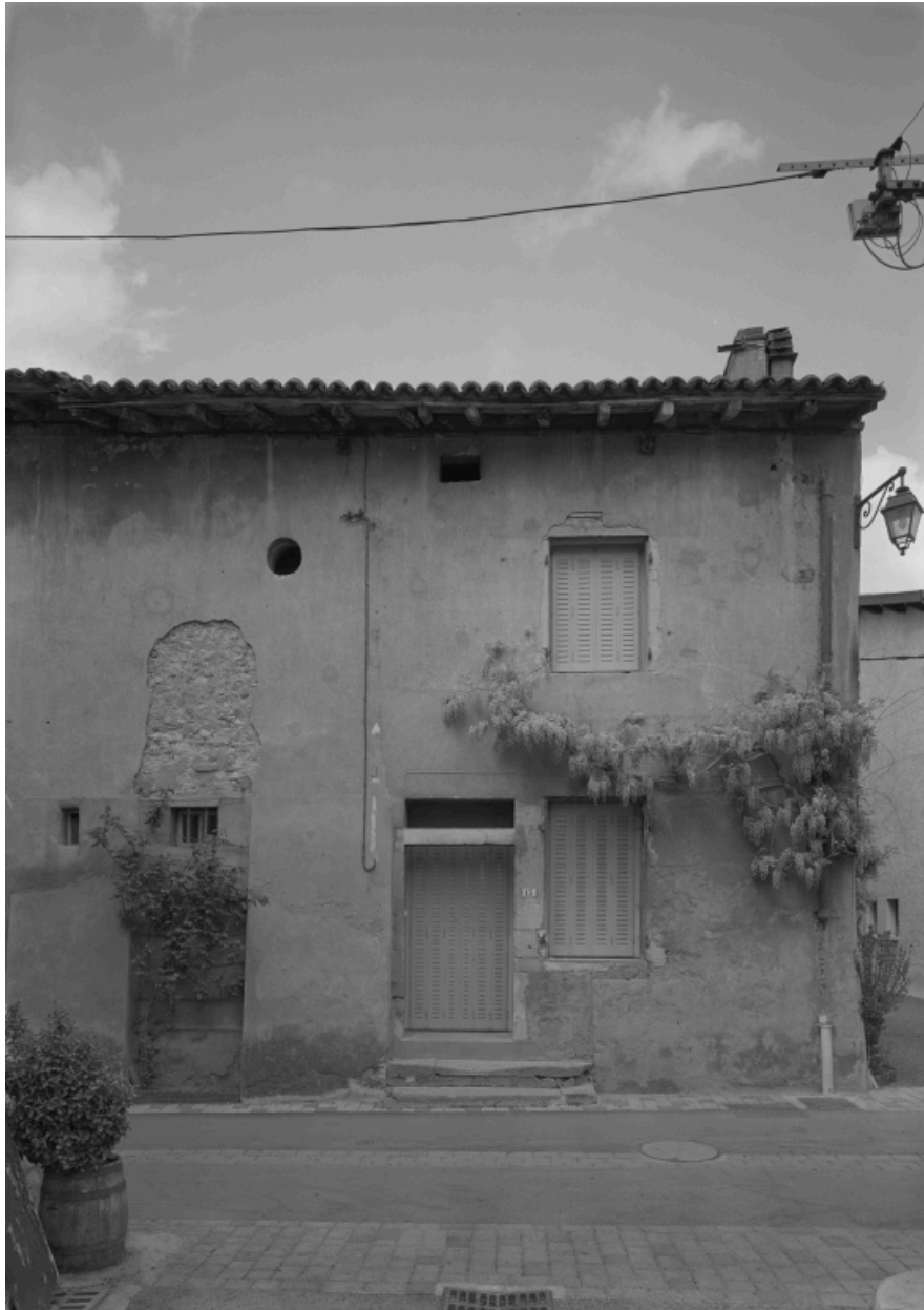
Maison de type IV, Saint-Bernard, élévation principale 15 rue de la Saône, vue partielle.
