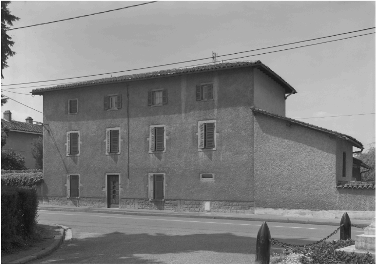
Maison de type V, Jassans-Riottier, 1376 rue Edouard Herriot : maison individuelle en pisé, construite en 1870.
