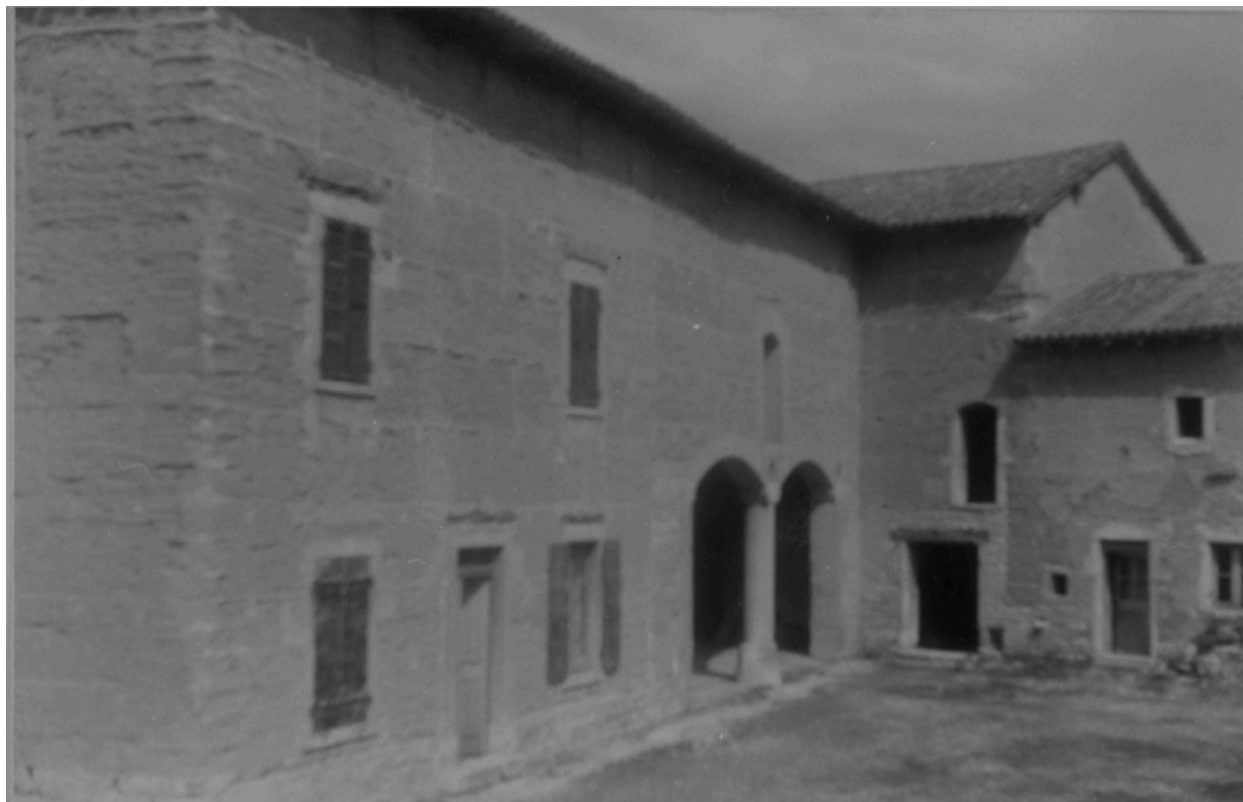
Maison de type VI (maison de maître), Saint-Didier-de-Formans, chemin Charbonnet : porche et logis avant restauration.
