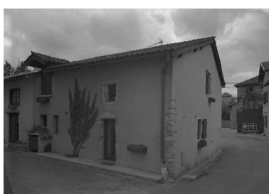
Maison de type II, Saint-Bernard, impasse des Glycines : une travée sur l'impasse, et anciennes dépendances remaniées à gauche. Phot. Jean-Marie Refflé IVR82_19920100393P
