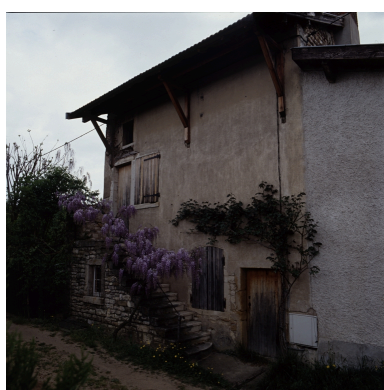
Maison de type I, Saint-Bernard, rue de la Saône : maison rurale en pisé, escalier extérieur couvert par l'avant-toit débordant sur aisseliers. Phot. Jean-Marie Refflé IVR82_19920100392XA
