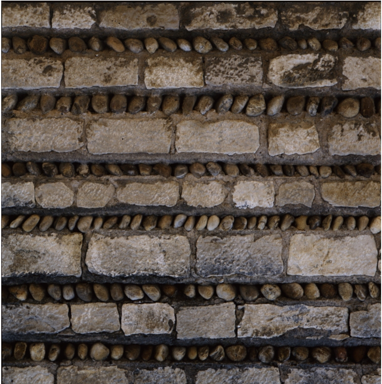
Maison de type VII, Jassans-Riottier, 56 rue du Cinier, détail de l'appareil du mur de clôture.
