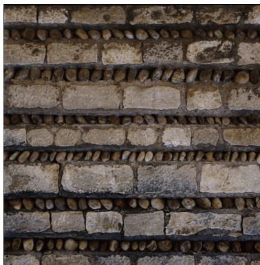
Maison de type VII, Jassans-Riottier, 56 rue du Cinier, détail de l'appareil du mur de clôture. Phot. Eric Dessert IVR82_19920100843XA
