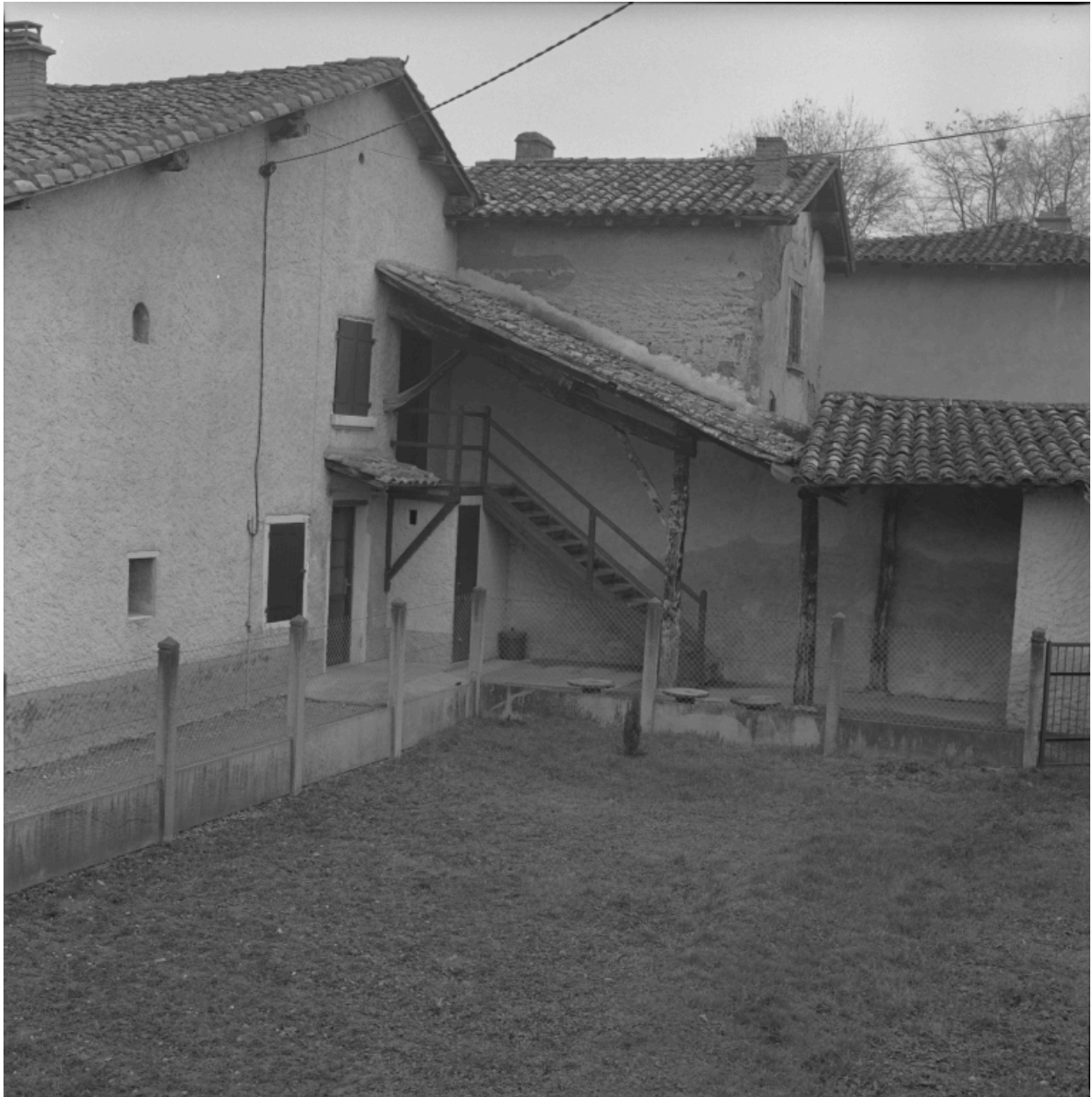
Maison de type I, Frans, chemin du Creuzat, 2e maison : maison rurale en pisé, escalier extérieur dans la cour protégé par un auvent.
