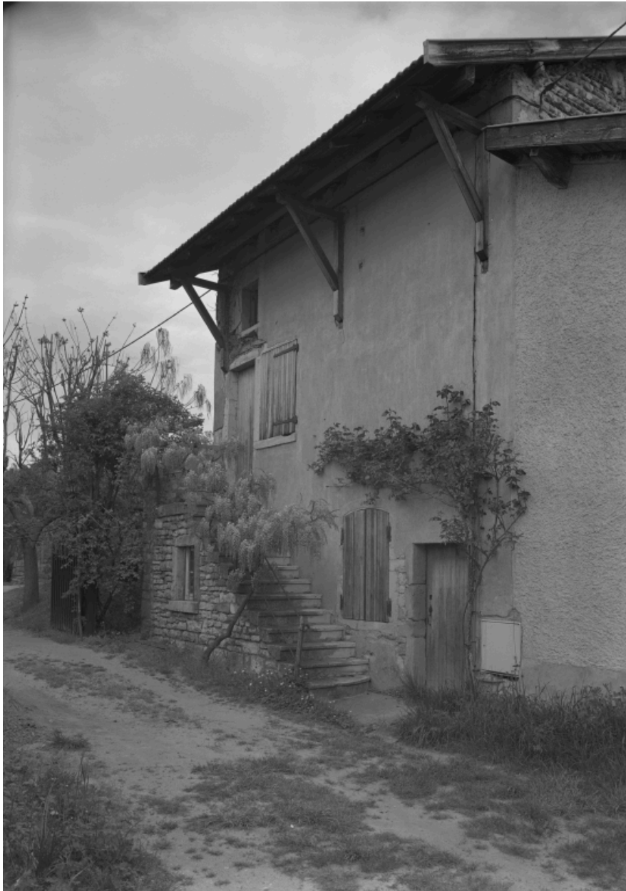
Maison de type I, Saint-Bernard, rue de la Saône : maison rurale en pisé, escalier extérieur couvert par l'avant-toit débordant sur aisseliers.
