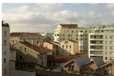
Vue du corps de bâtiment nord depuis l'est Phot. Maryannick Chalabi IVR82_20086900674NUCA
