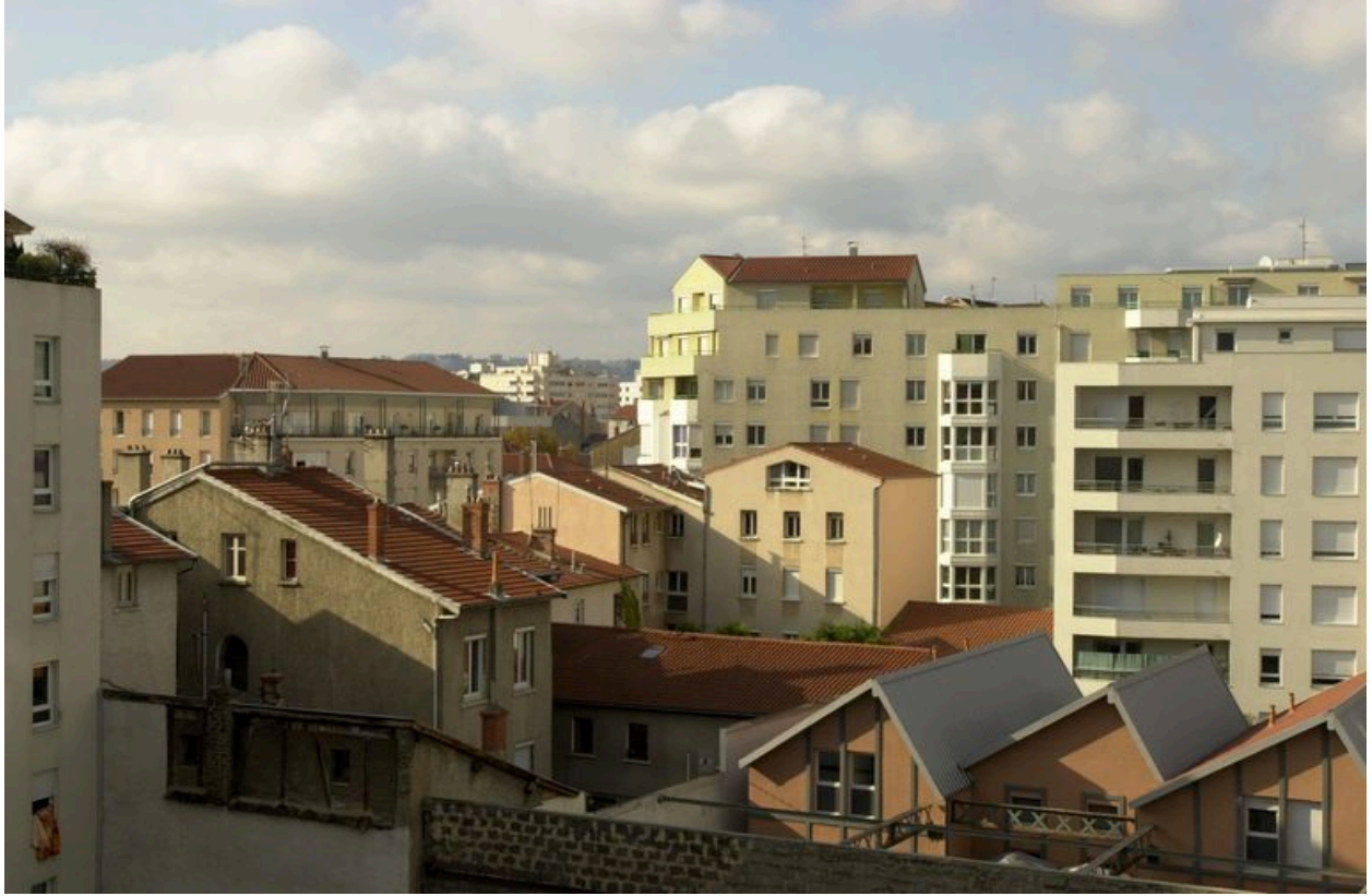
Vue du corps de bâtiment nord depuis l'est
