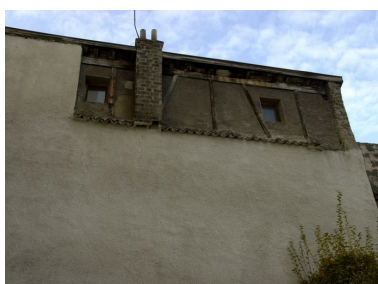
Elévation est du corps de bâtiment nord : détail du dernier étage Phot. Maryannick Chalabi IVR82_20086900713NUCA
