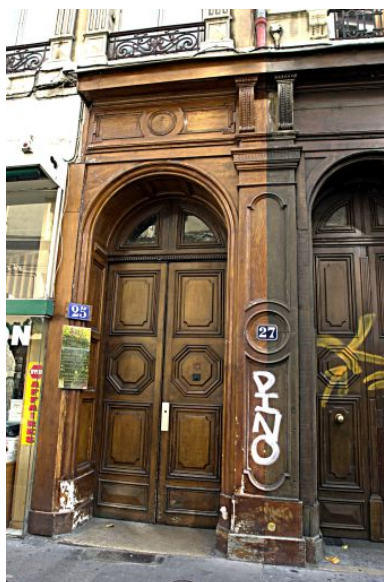
Façade principale, détail de la porte Phot. Maryannick Chalabi IVR82_20046900176NUCA
