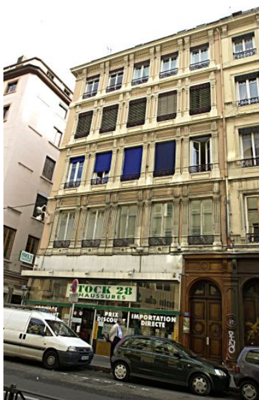
Façade principale, vue générale Phot. Maryannick Chalabi IVR82_20046900174NUCA
