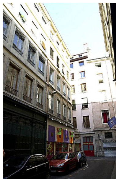
Façade sur la rue Pléney Phot. Bernard Ducouret IVR82_20046900178NUCA
