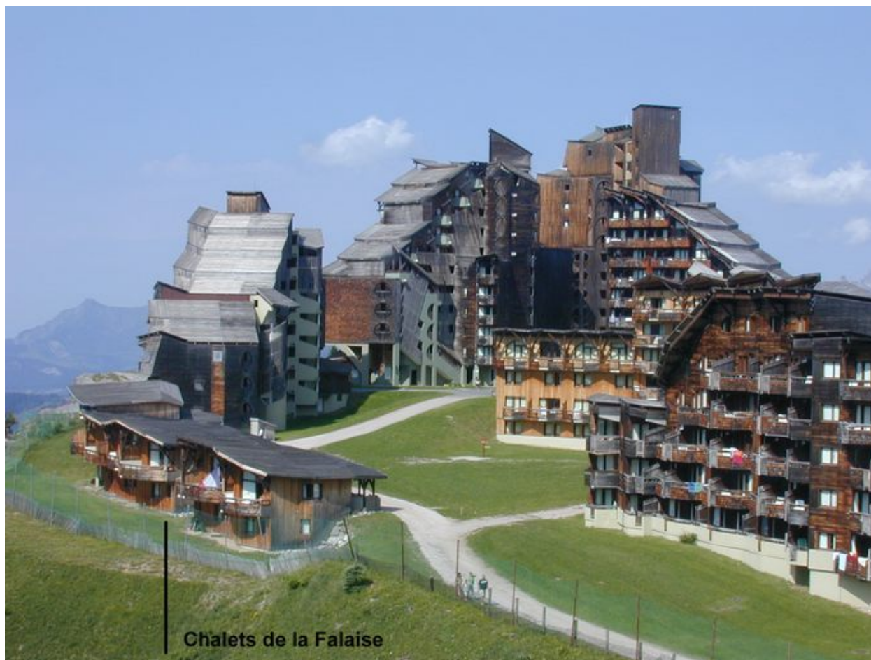
Vue d'ensemble depuis le nord-nord-est
