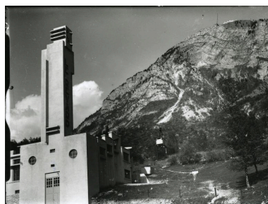
Vue d'ensemble : gare inférieure, tracé et gare supérieure Repro. Denys Harreau IVR84_20167305327NUCB
