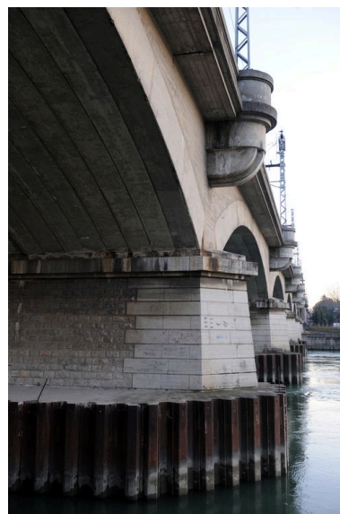
Vue partielle, de côté, face aval (depuis la rive droite) Phot. G. Gellert IVR82_20106907128NUCA
