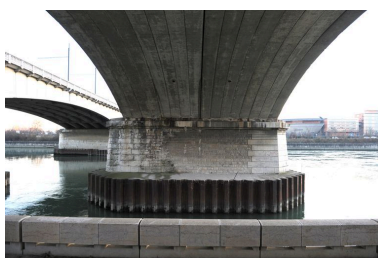
Vue partielle, de dessous, arche et pile (depuis la rive droite) Phot. G. Gellert IVR82_20106907127NUCA
