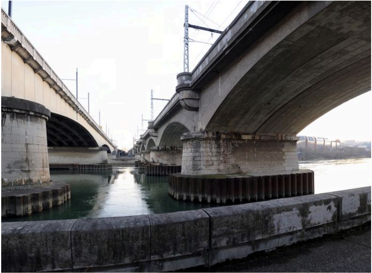
Vue générale, face amont, de côté (depuis la rive droite) ; le pont Poincaré sur la gauche
