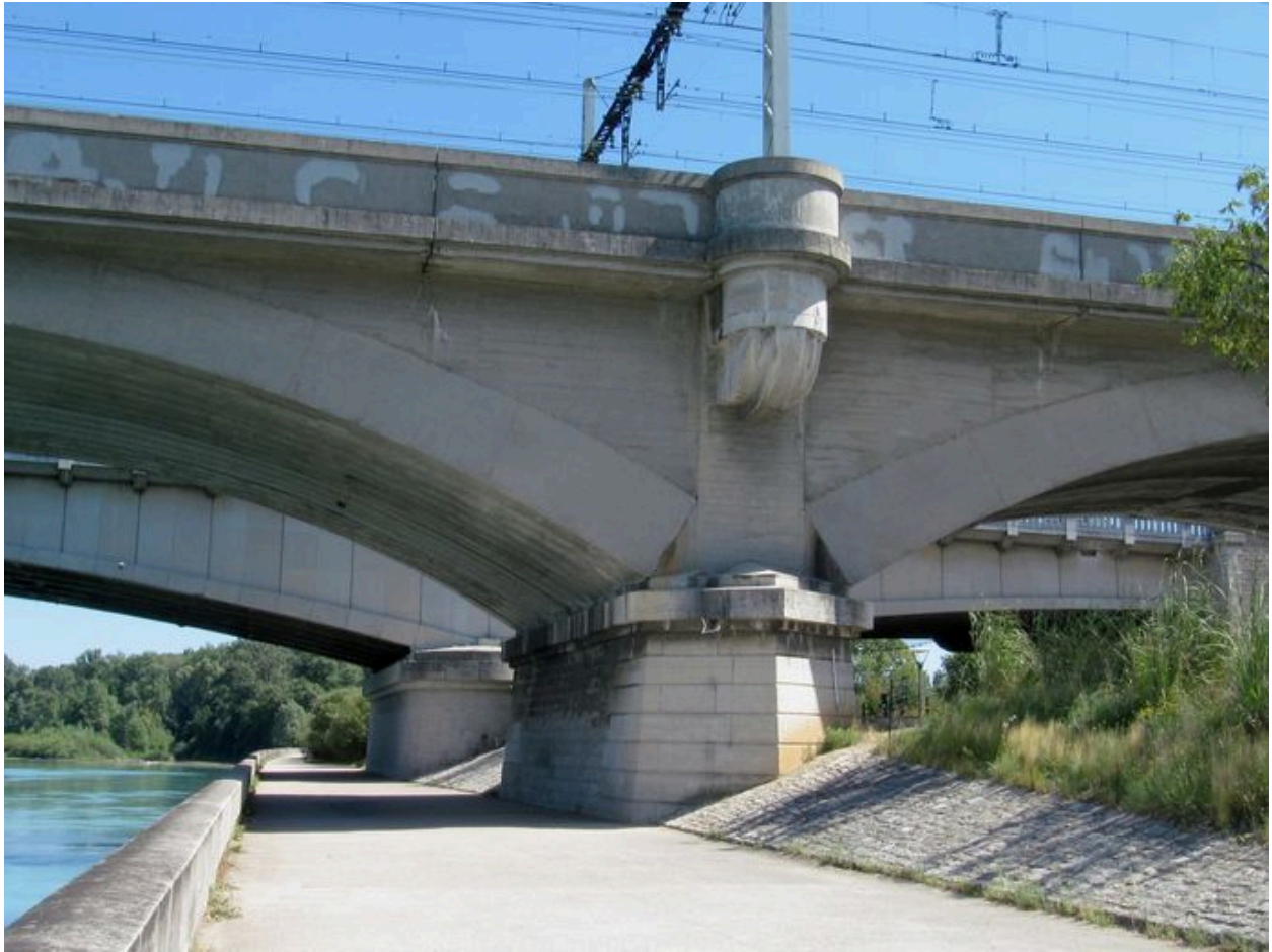
Vue partielle, pile de rive gauche, face aval (depuis la rive gauche)
