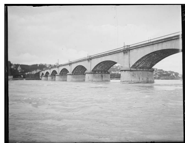
[Pont du chemin de fer à Saint-Clair] / Paul Lancrenon phot., [03/07/1898]. 1 photogr. nég. : n. et b. (Médiathèque de l'Architecture et du Patrimoine, Archives photographiques, SAP 05, LCR00700) Phot. Médiathèque de l'Architecture et du Patrimoine, Autr. Paul (photographe) Lancrenon IVR82_20106902657NUCAB
