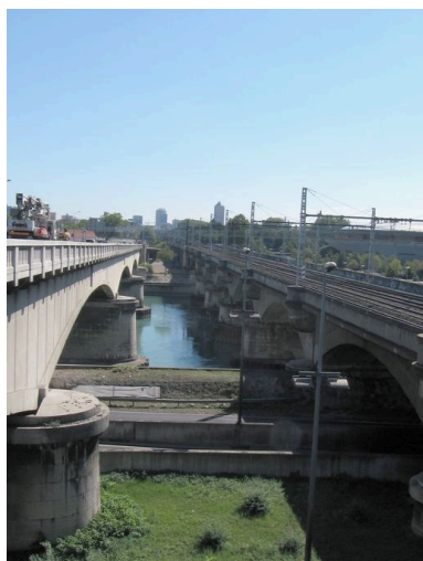
Vue générale, de dessus, face amont (depuis la rive droite) ; le pont Poincaré sur la gauche Phot. I. Havard IVR82_20106907132NUCA
