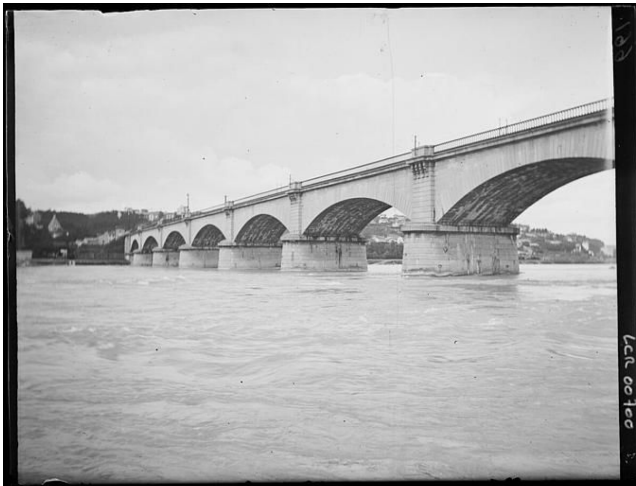
[Pont du chemin de fer à Saint-Clair] / Paul Lancrenon phot., [03/07/1898]. 1 fotogr. nég. : n. et b. (Médiathèque de l'Architecture et du Patrimoine, Archives photographiques, SAP 05, LCR00700)
