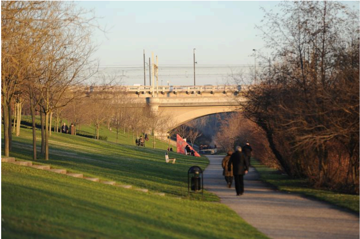
Vue partielle, pile de rive droite, face aval (depuis la rive droite)
