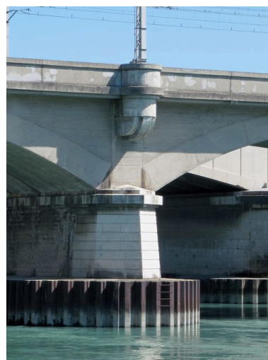
Vue partielle, pile, face aval (depuis la rive droite) Phot. I. Havard IVR82_20106907136NUCA
