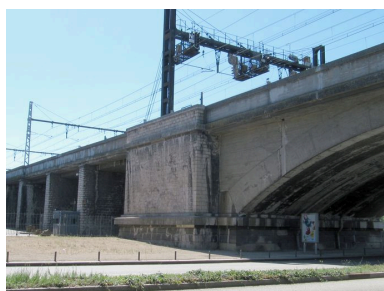
Vue partielle, culée gauche, face amont (depuis la rive gauche) Phot. I. Havard IVR82_20106907134NUCA
