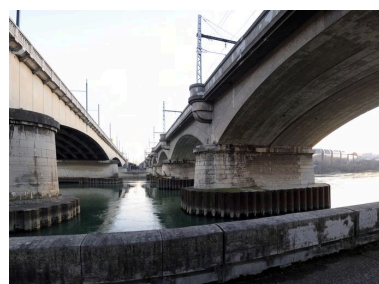
Vue générale, face amont, de côté (depuis la rive droite) ; le pont Poincaré sur la gauche Phot. G. Gellert IVR82_20106907129NUCA
