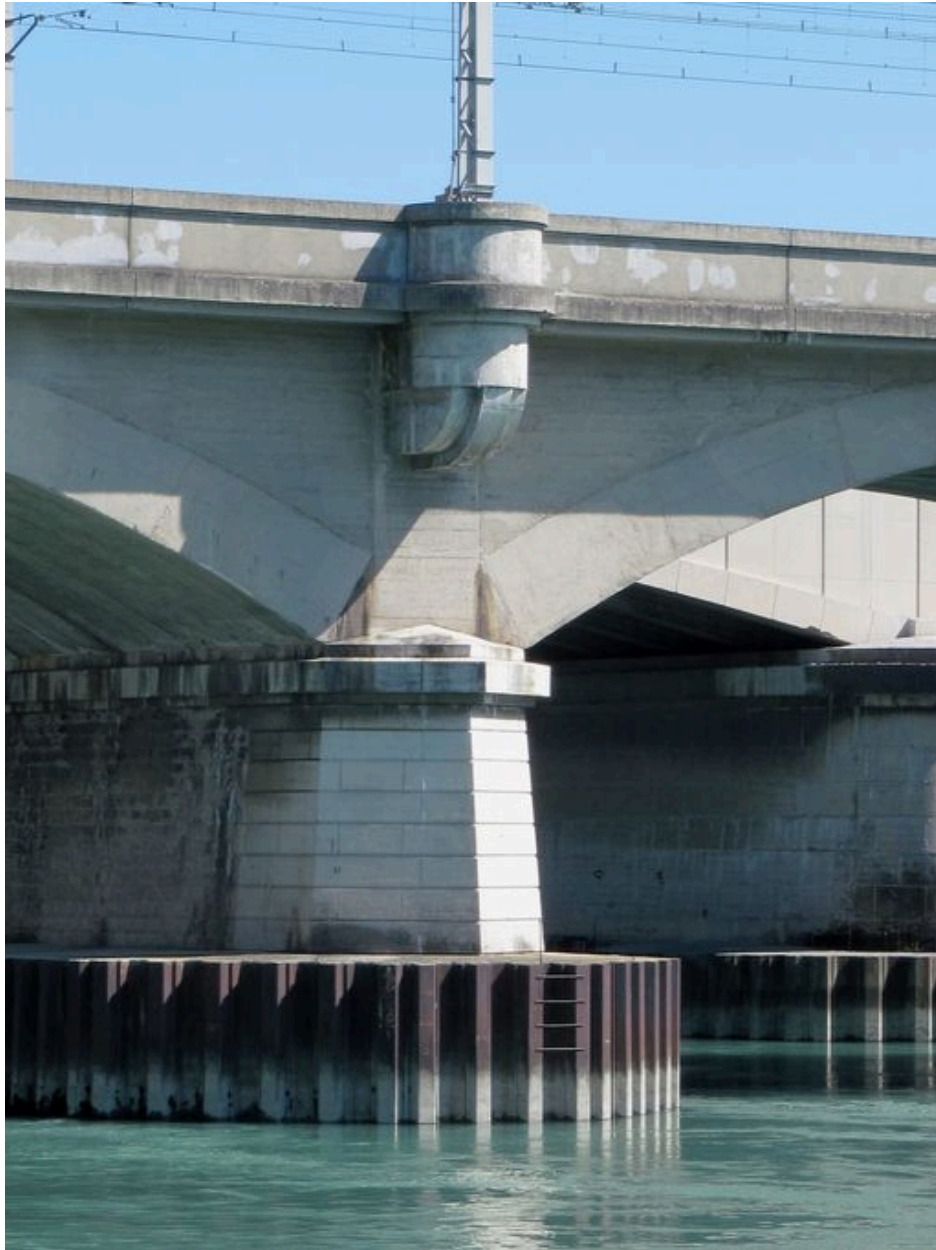
Vue partielle, pile, face aval (depuis la rive droite)
