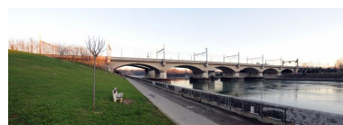
Vue panoramique, face aval (depuis la rive droite) Phot. G. Gellert IVR82_20106907125NUCAQ
