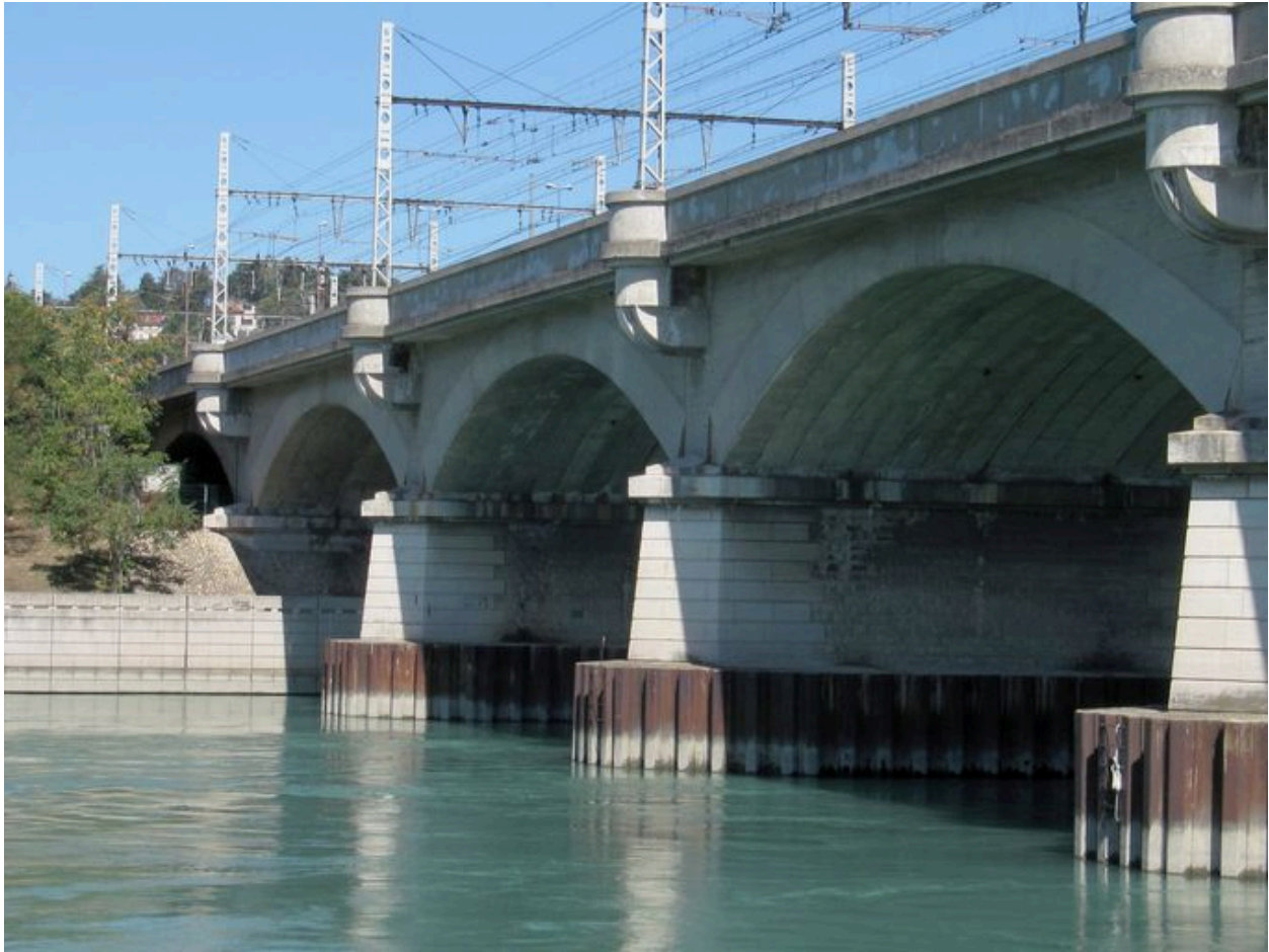
Vue partielle, travées de droite, face aval (depuis la rive gauche)
