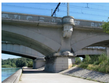
Vue partielle, pile de rive gauche, face aval (depuis la rive gauche) Phot. I. Havard IVR82_20106907135NUCA
